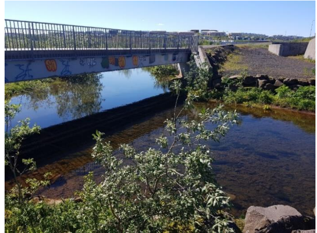
Mynd 4: Göngubrú yfir Úlfarsá. Í tillögu 1 er gert ráð fyrir að nota þessa lagnaleið
