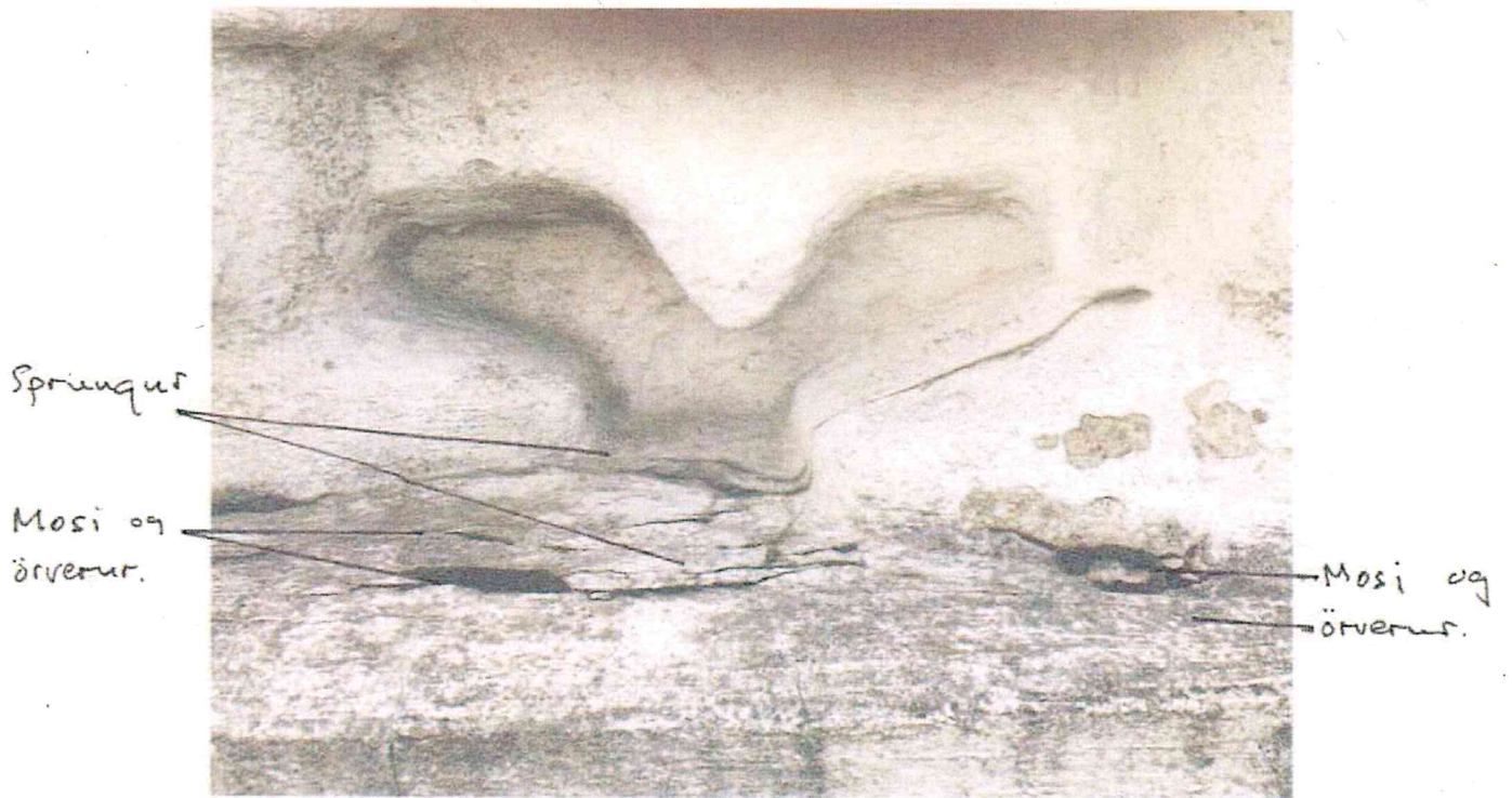
Mynd 2. Nærmynd af fótstykki við sökkul. Sjá má lausar sprunguflögur, mosa og örverugróður.
