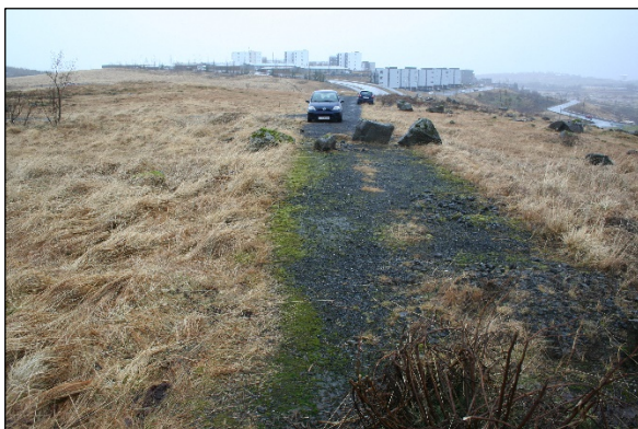
Mynd 50. Langavatnsvegur (257-26) vestan við Hólmsheiðarveg, horft í vestur að Grafarholti.
