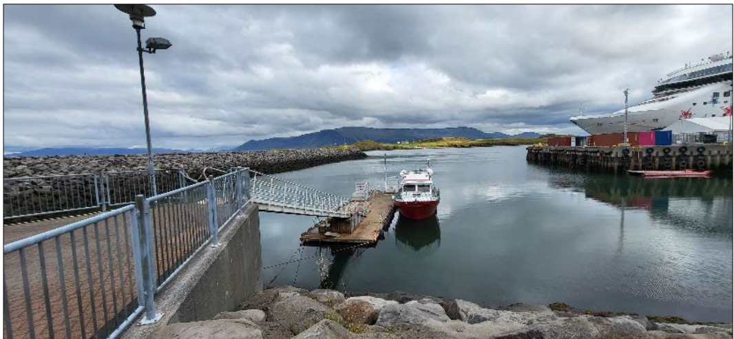
Bryggja og landgöngubrú séð austan megin
