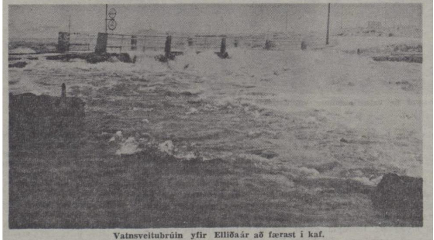
Vatnsveitubruin yfir Elliðaár að færast í kal.
