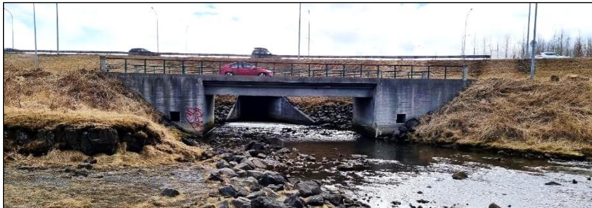
Mynd 38. Brúin yfir vestari kvísl Elliðaárna reist 1941, horft í suður.
