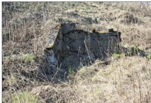
Mynd 31. Steinsteipt húshorn, leifar af húsi við Grund.
