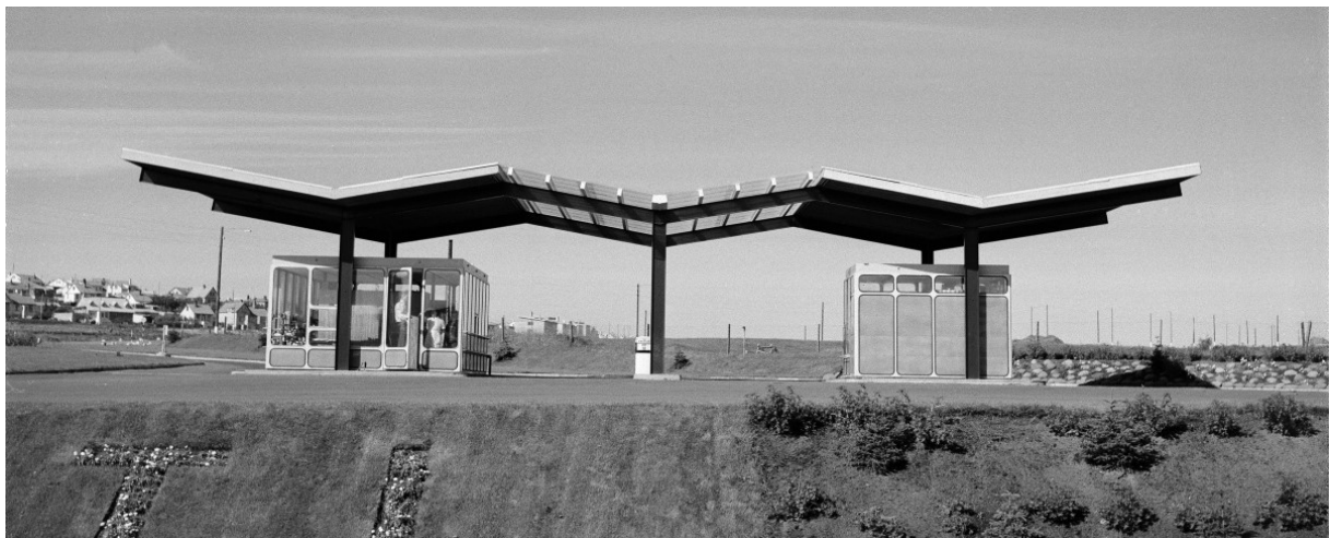
Mynd 7 Nesti við Suðurlandsbraut (Elliðaárvog), árið 1959. Stöðina hannaði Manfréd Vilhjálmsson arkitekt. 33
