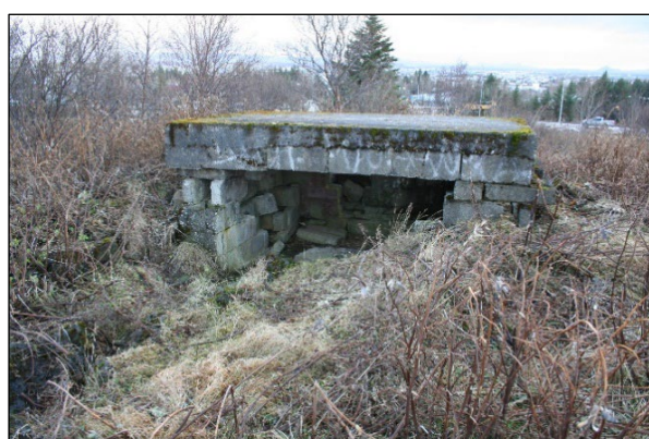
Mynd 32. Skotbyrgi (5-217), horft til suðurs að Bústaðavegi.
