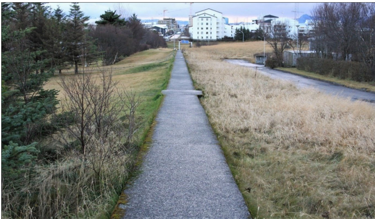
Mynd 17. Stokkurinn/Reykjaæð, horft til suðausturs að Ofanleiti.
