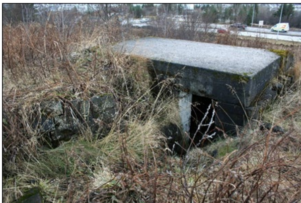
Mynd 28. Skotbyrgi (5-216), horft til suðurs að Bústaðavegi.
