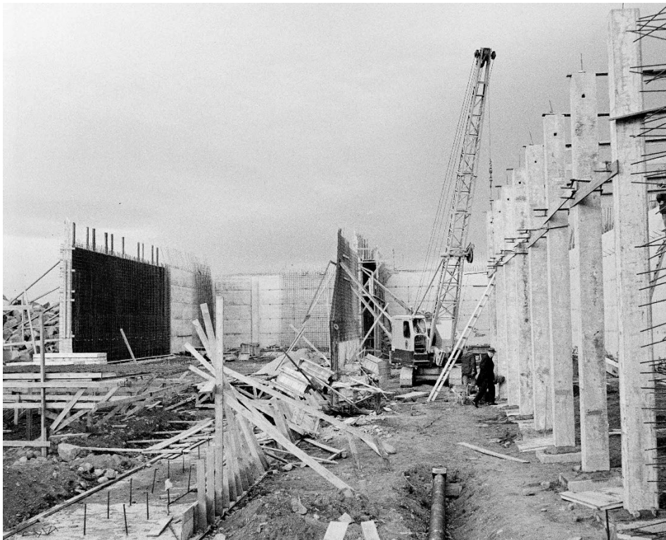
Mynd 15 Unnið að byggingu vatnsgeymisins í Litluhlíð í febrúar 1964. 53
