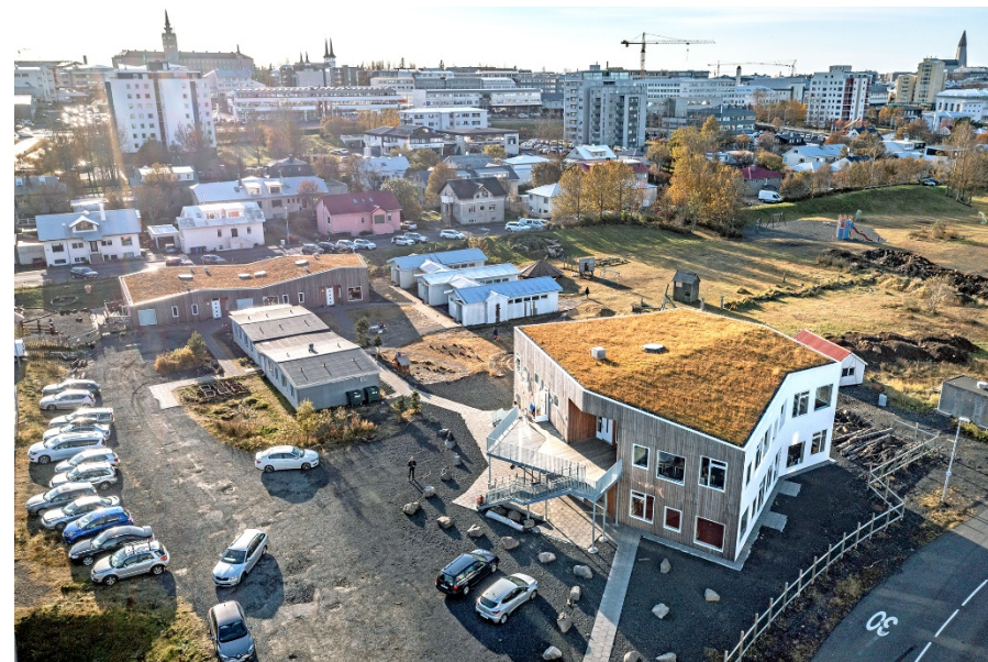
Waldorfskólinn Sólstafrinn í Reykjavík er úr sérhönnuðum krosslímdum timbureiningum frá Element. Umsjón með byggingu skólans hafði Mannverk ehf. en aðalhönnuðir voru Basalt arkitektar.
