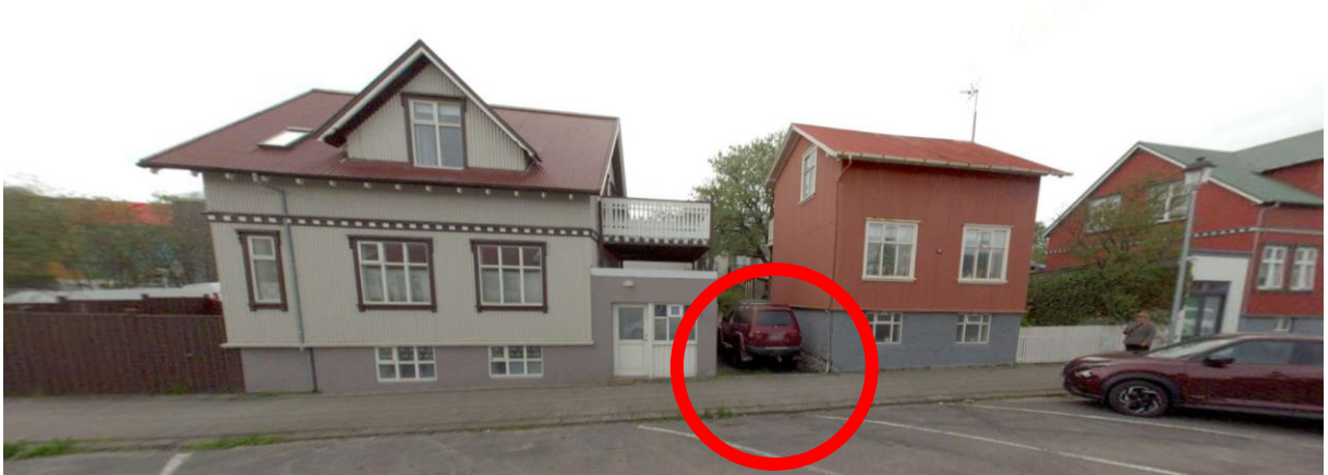
Njálsgata nr. 42 við miðju. Innsýn frá götu að viðbyggingarreit á baklóð. Óleyfisbílstaði merkt innan rauðs hring. Mynd tekin í júní 2023.
