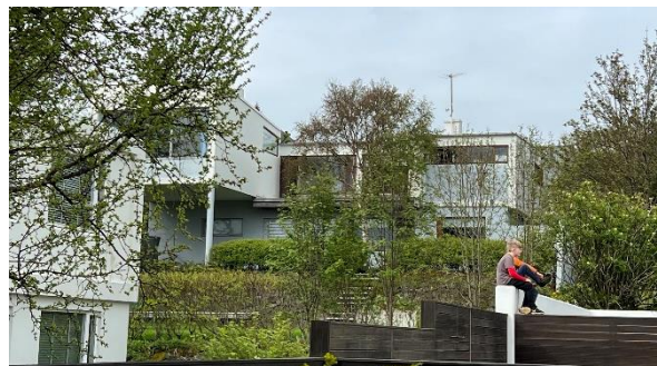
Garðhlið hússins séð frá Sunnuvegi. Þar sést samspil húskropps, útbyggingar og lóðar.
