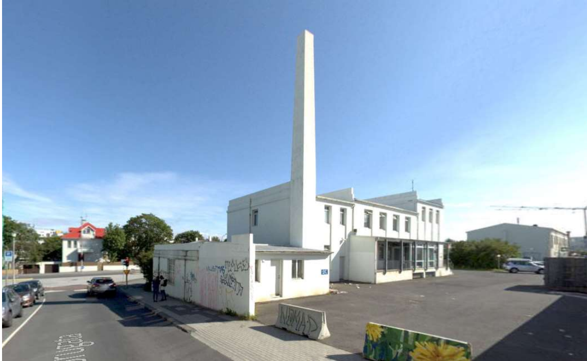
Núverandi hús séð frá Bergþórugötu: Ketilhús, skorsteinn og núverandi anddyrisviðbygging
