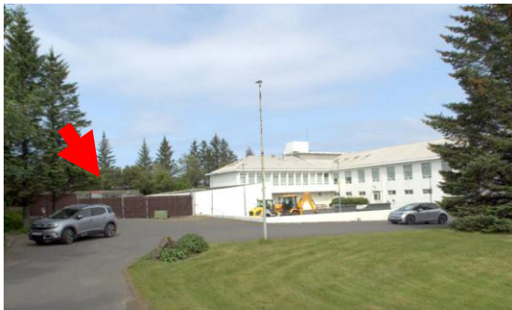
Húsið sem skemman á að standa upp við.
