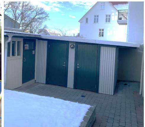
Viðbygging við geymsluskúr
