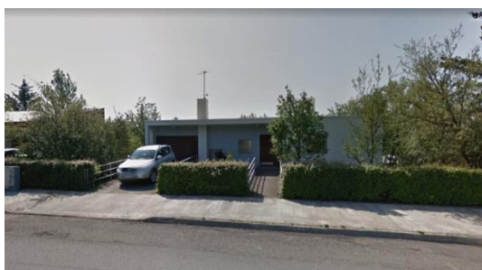
Húsið að Laugarásvegi 52 séð frá götu fyrir framkvæmdir. Þar sést hvernig aðkoma að húsinu er um brú milli húss og götu yfir garði.
