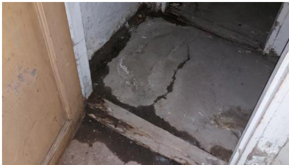
Raki og bleyta ásamt mikillar rakaútfellingar og fúkkalykt í kjallara sbr. skýrslum og úttektum
