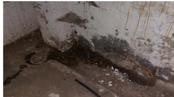
Raki og bleyta ásamt mikillar rakaútfellingar og fúkkalykt í kjallara sbr. skýrslum og úttektum
