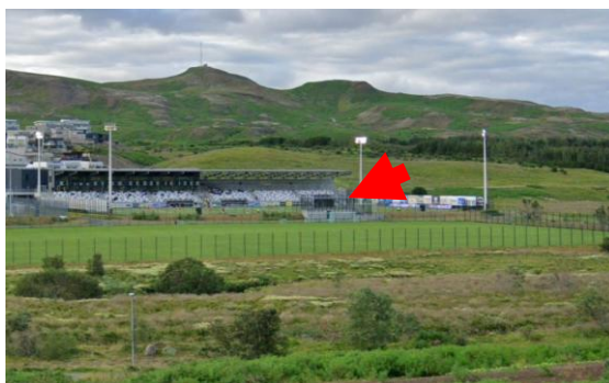
Séð á dæluhús frá Reynisvatnsvegi
