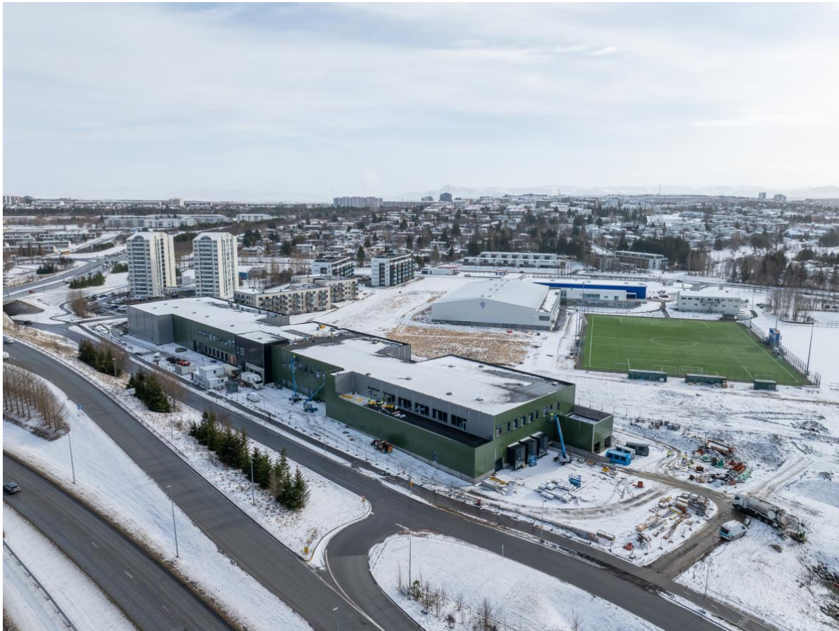
Mynd 3.1 Loftmynd sem tekin er til suðurs yfir frárein Reykjanesbrautar-Breiðholtsbrautar og Álfabakka þar sem fyrirhuguð kjötvinnsla Ferskra kjötvara verður staðsett í vesturhluta byggingarinnar við Álfabakka 2a. Sunnan við bygginguna er íþróttasvæði Íþróttafélags Reykjavíkur og til vinstri fjölbýlishús við Árskóga.
