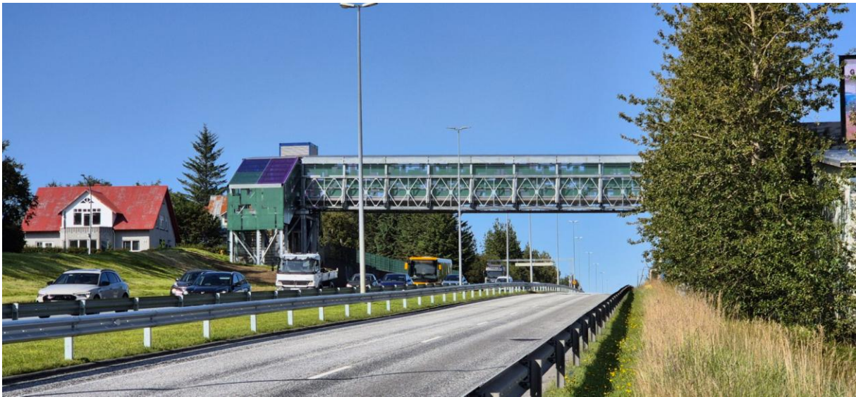
Mynd 4.2 Búið er að setja upp göngubrá yfir Sæbraut á mótis við Snekkjuvog sem verður færð til á framkvæmdatíma og tekin niður þegar bílaumferð er komin í stokkinn. 30
