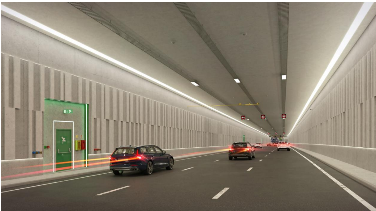
Mynd 4.8 Mögulegt útlit innan í stokk með ljósum, loftblásurum (í fjarska), neyðardryrjum á milli hólfa og öðrum öryggisbúnaði, s.s. neyðarsíma og slökkvivatnsstútum við flóttaleið, myndavél og hraðamyndavélum (gular).
