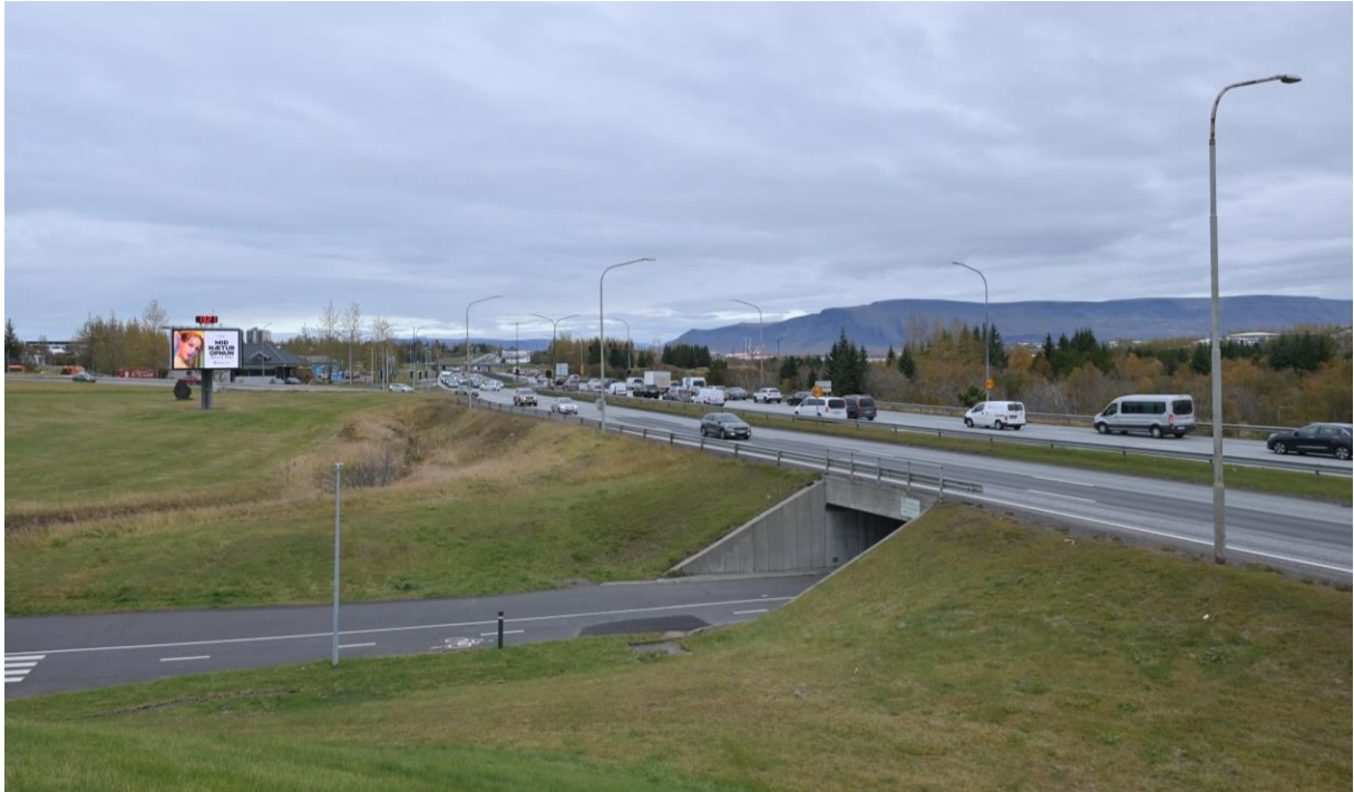
MYND 5.20 Landslag á fyrirhuguðu framkvæmdasvæði, horft til norðurs. Mynd sýnir gatnamót Reykjanesbrautar og Bústaðavegar frá jaðri íbúðahverfisins í Blesugróf. Syðri undirgöngin undir Reykjanesbraut í forgrunni. Mynd: EFLA, 2023.
