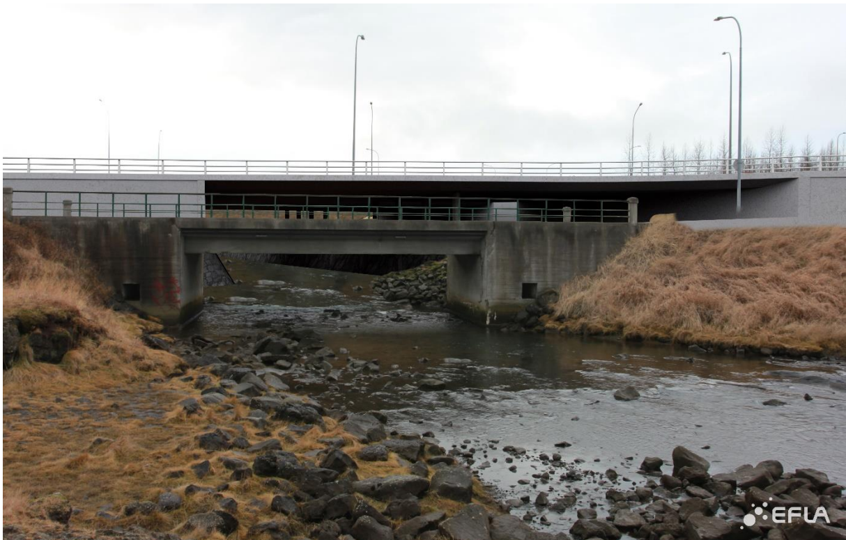
MYND 5.37 Sjónarhorn 7 (eftir). Horft til suðurs frá Elliðaárósum við Geirsnef. Á myndinni sést hvernig vestari kvísl Elliðaánna rennur um breikkaðan stokk undir Vesturlandsveg.
