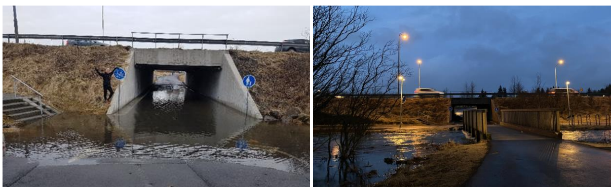
MYND 5.41 Undirgöng undir Reykjanesbraut eftir flóð í Elliðaánum í febrúar 2018 (t.v.). Brú yfir vestari kvísl Elliðaána í febrúar 2023 (t.h.). Ljós. EFLA.
