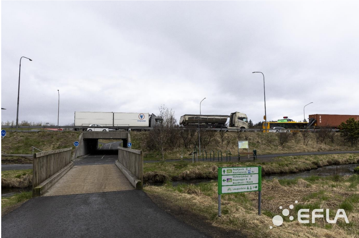
MYND 5.30 Sjónarhorn 5 (fyrir). Horft til vesturs úr Elliðaárdal, séð yfir undirgöng göngu- og hólastígs undir Reykjanesbraut.
