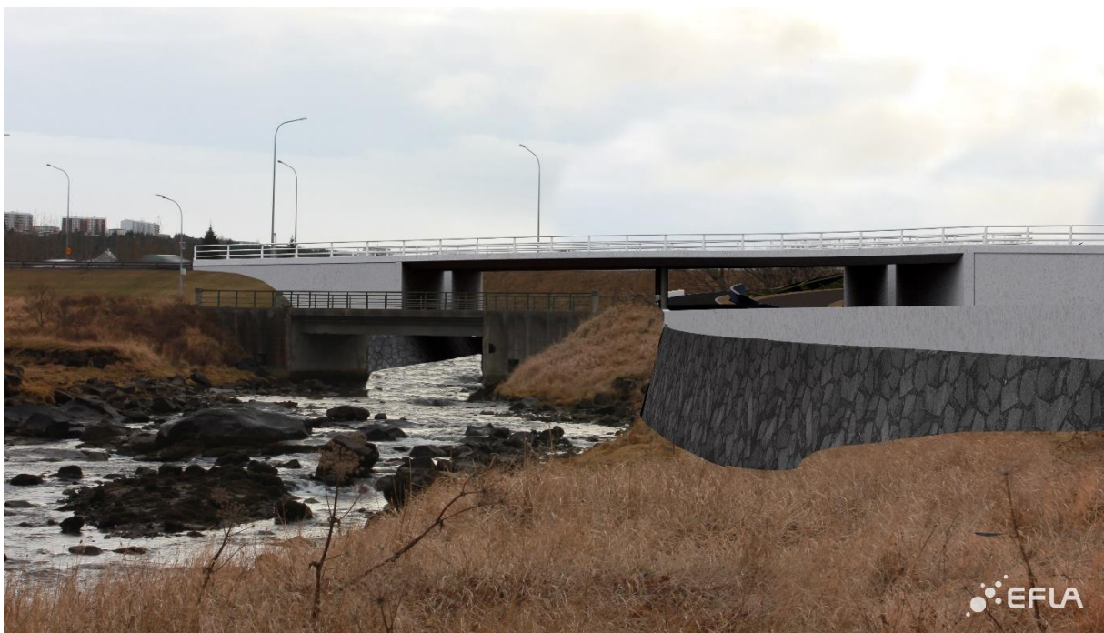
MYND 5.39 Sjónarhorn 7 (eftir). Horft til suðurausturs frá Elliðaárósum við Geirsnef. Á myndinni sést hvernig vestari kvísl Elliðaárna rennur um breikkaðan stokk undir Vesturlandsveg.
