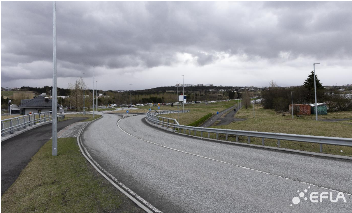
MYND 5.22 Sjónarhorn 1 (fyrir). Horft til austurs í átt að Reykjanesbraut frá Bústaðavegi. Myndin sýnir hringtorg við Bústaðaveg. Til vinstri má sjá byggingar á Sprengisandi og til hægri má sjá göngu- og hjólastíg. Elliðaárdalur og Breiðholt eru í bakgrunni.
