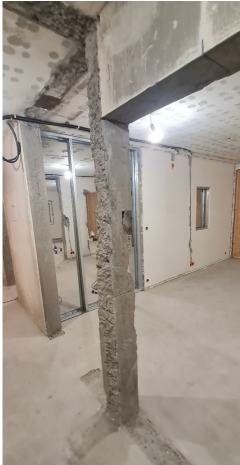
Mynd 2.8 - Súla sem stendur ein eftir að innveggir í kring hafa verið fjarlægðir. Súlan er 200x200mm og þversnið hennar er rýrt af rafmagnsdós. Súlan sem eftir stendur er ekki með fullnægjandi járnbindingu.
