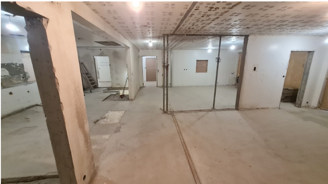
Mynd 2.9 - Hluti innveggjar hefur verið fjarlægður. Hér hefur verktaki sett stoðir undir þakplötuna í stað veggjarins sem var fjarlægður.
