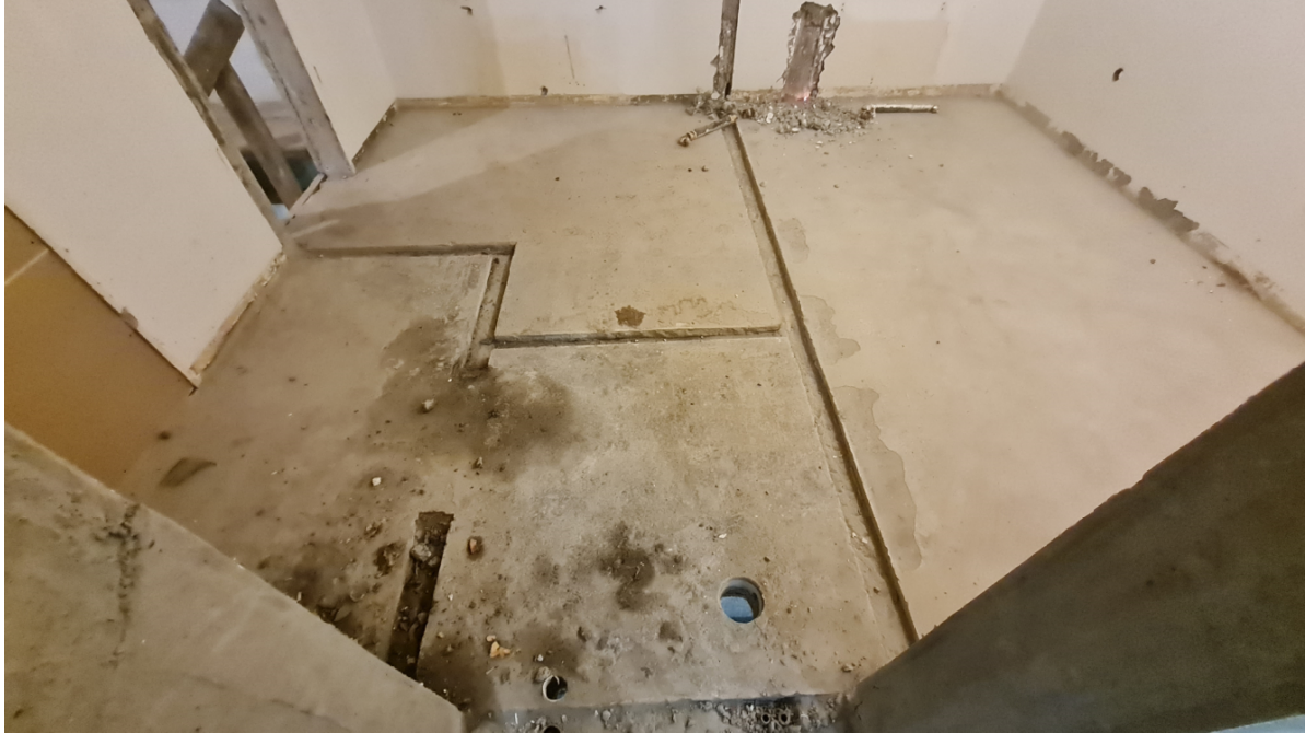
Mynd 2.13 – Hér má sjá hvernig illögn hefur verið sett upp að léttum innveggjum sem hafa verið fjarlægðir.
