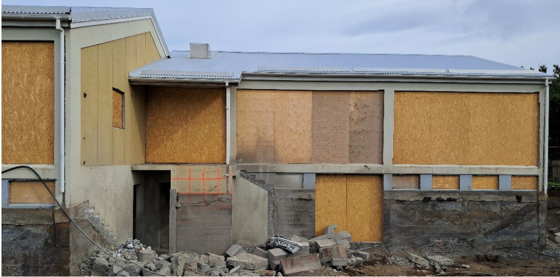
Mynd 2.11 - Ásýnd á núverandi ástand suðurveggjar einnar álmu Leirulækjar 6. Búið er að saga eitt af götunum á kjallaravegg þessarar álmu.
