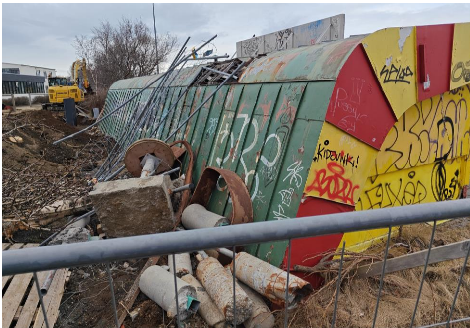
Mynd 4.26 Æskilegt væri að tryggja að Sunnutorg verði ekki fyrir nánari skemmdum, meðan ákveðið er hvað skal gera með húsnæðið, með að byrgja það inni.
