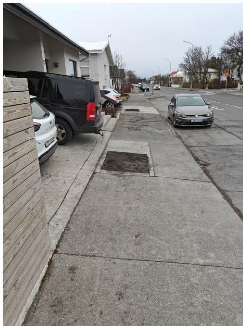
Mynd 4.17 Tvær holur í gangstéttum sem ekki er varað við. Við Langholtsveg 21.
