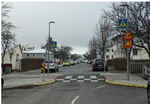
Mynd 5.1 Gönguþverun og hraðatakmarkandi aðgerð við Skipasund 76.
