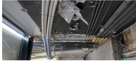
Mynd 5-22: Búið að fjarlægja ljós og annan búnað.
