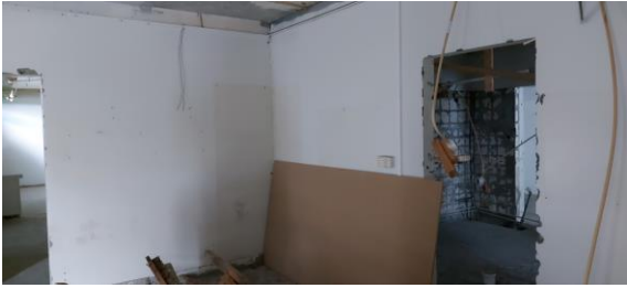
Mynd 5-21: Búið að fjarlægja ljós og annan búnað.
