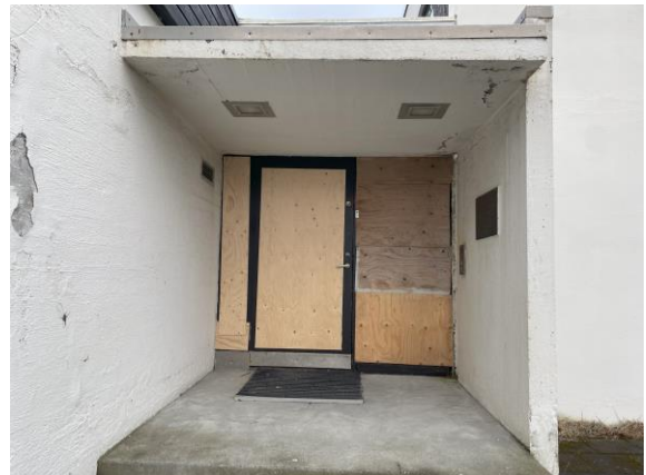
Mynd 5-4: Málning farin að flagna af útvegg
