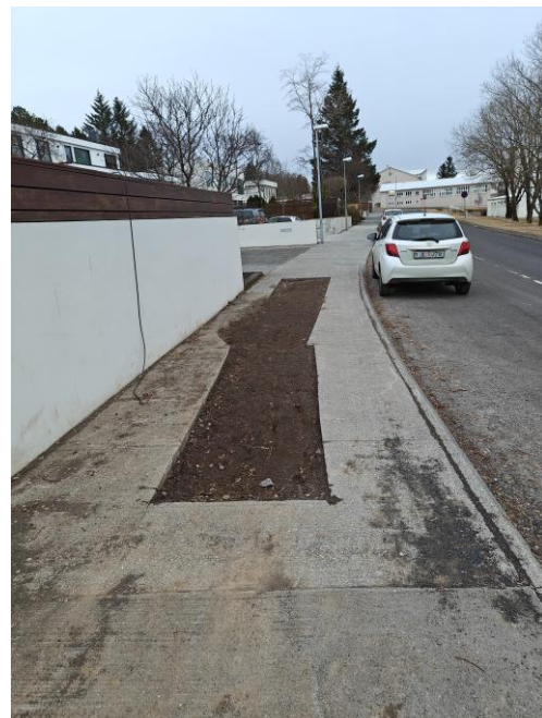
Mynd 4.18 Löng hola í gangstétt sem ekki er varað við. Við Sunnuveg 27.
