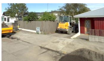
Mynd 4.28 Bílastæði við Langholtsveg 55 (mynd frá ja.is).
