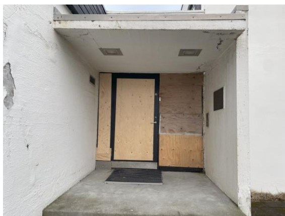
Mynd 5-4: Málning farin að flagna af útvegg
