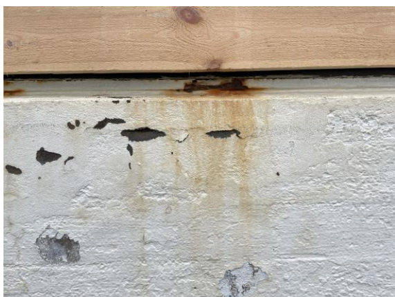
Mynd 5-3: Ryðpunktur undir glugga og málning að flagna af.
