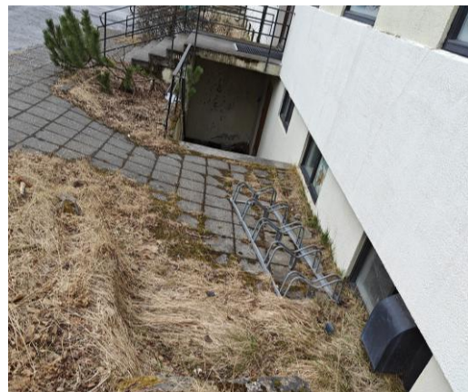
Mynd 4.24 Hjólastæði sem eru við inngang við Dyngjuveg. Fjarlægja þarf gróður við hjólastæðið, festa það niður og staðsetja það betur fjær tröppunum niður í kjallara. Hjólastæði þetta uppfyllir fáar kröfur sem gerðar eru til hjólastæða í hönnunarleiðbeiningum fyrir hjólreiðar.
