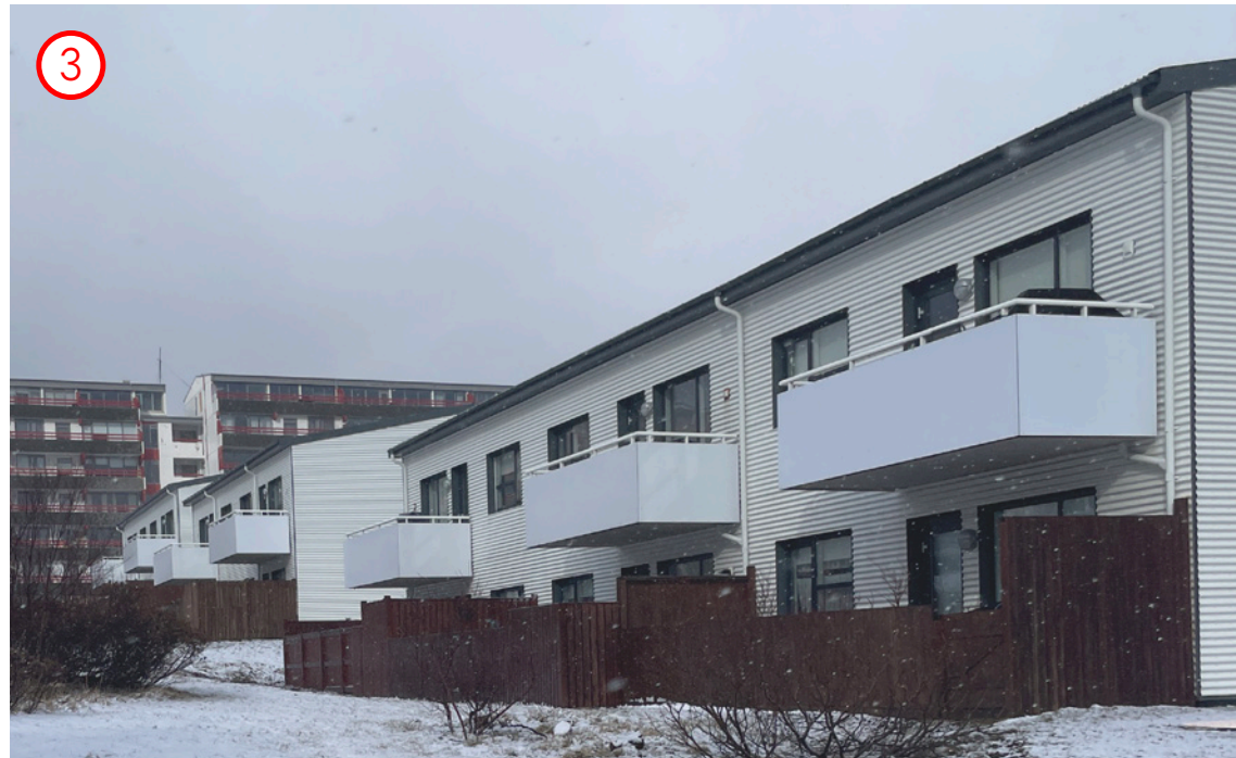
3.Suðurfell – 2. hæða fjölbýlishús með litlum einkagörðum vestan megin og bílastæðum autanmeginn.
