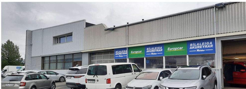
Mynd 3.3. Ál- og aluzink klæðning byggingar.
