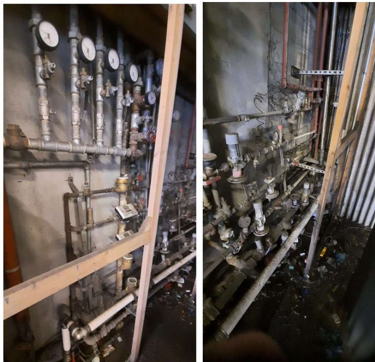
Mynd 2.2. Hitaveitulagnagrind.
