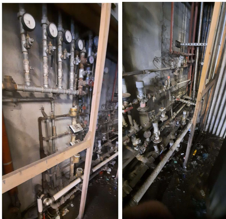
Mynd 2.2. Hitaveitulagnagrind.
