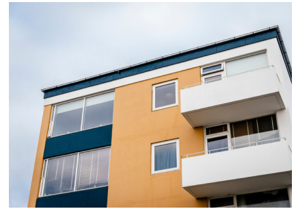
MYND 2 Svalir, gluggar, innfellingar og litafletir gefa húsinu einkennandi útlit. Fjölbýlishús við Háleitisbraut frá 1960.
