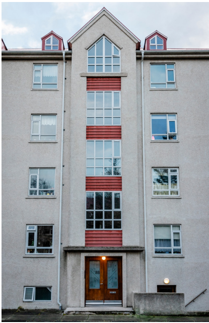
MYND 14 Inngangur og stigahús í fjölbýlishúsi við Birkimel.
