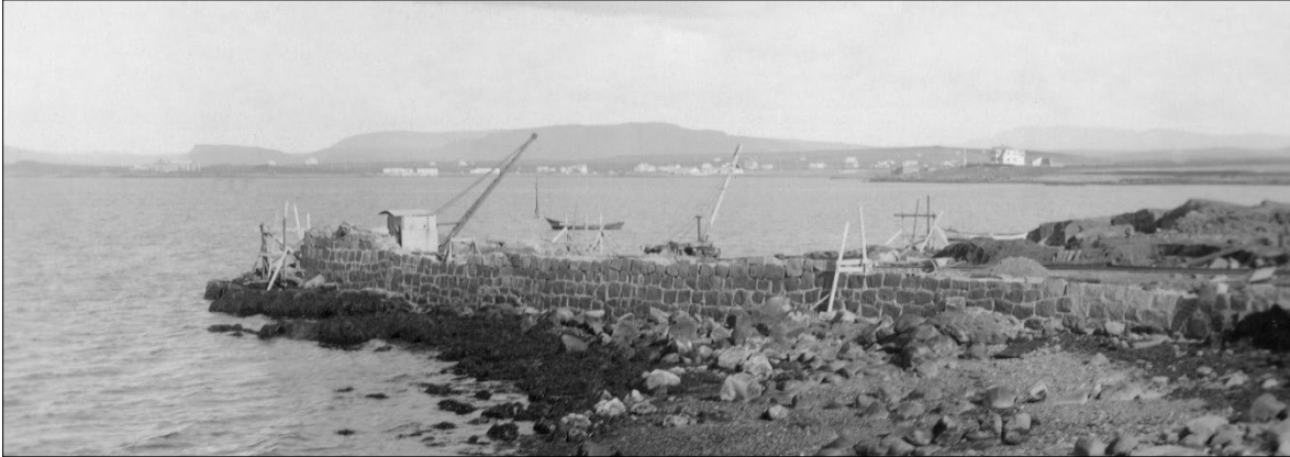
Mynd 7. Unnið við uppbyggingu á bólverki við Klöpp, þar sem Olústöð B.P. við Skúlagötu reis. Til hægri á myndinni eru klappirnar sem Klöpp var kennd við og Klapparvör fremst á myndinni. 22
