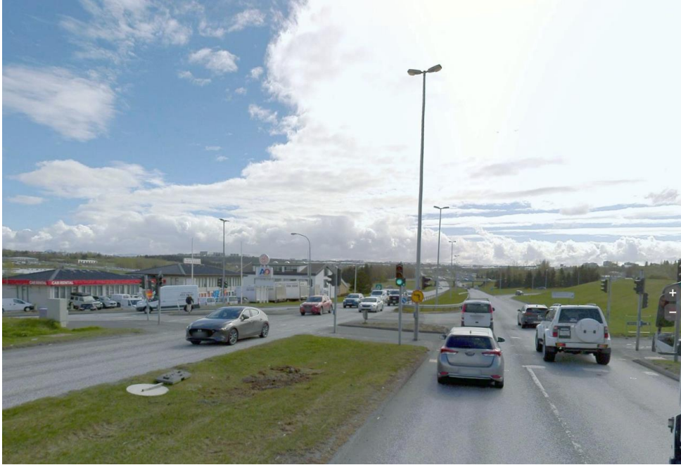
Mynd 9 Horft til suðurs að gatnamótum við Súðarvog en á þessum stað mun Borgarfirna þvera svæðið. (mynd úr gagnagrunni COWI)
