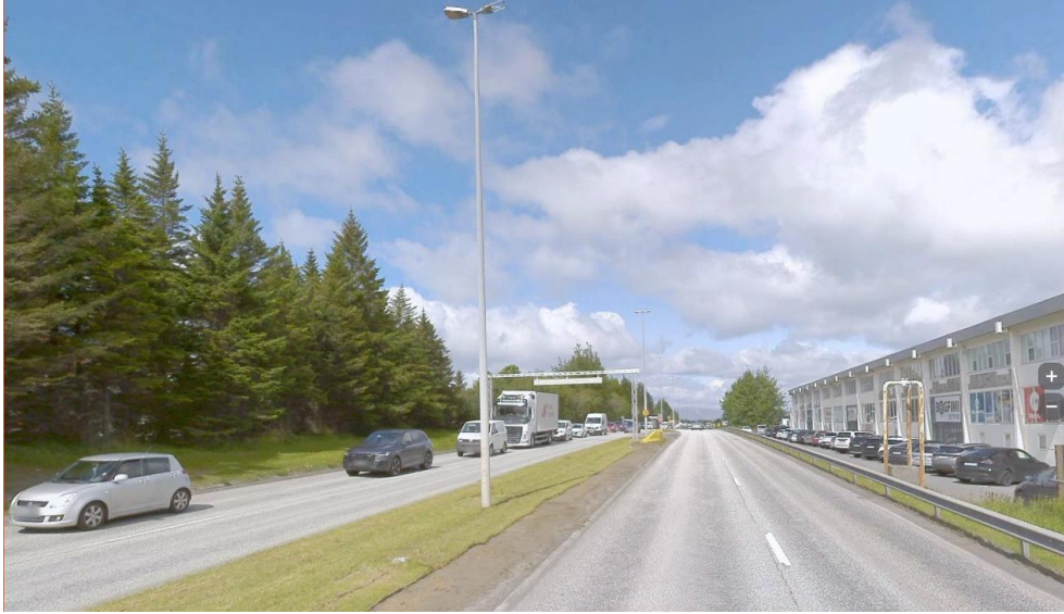
Mynd 7 Horft til norðurs. Tvær akreinar í báðar áttir, vestan megin mön með trjágróðri og austan megin vegrið og bílastæði framán við atvinnuhúsnæði. (mynd úr gagnagrunni COWI)
