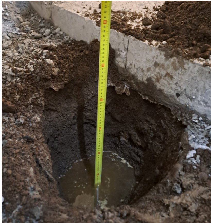
Mynd 2.1 - Prufuhola sem mokuð var í verðandi lagnaleið sem söguð var í botnplötuna. Mynd: Ólafur Már Lárusson, Verkís
