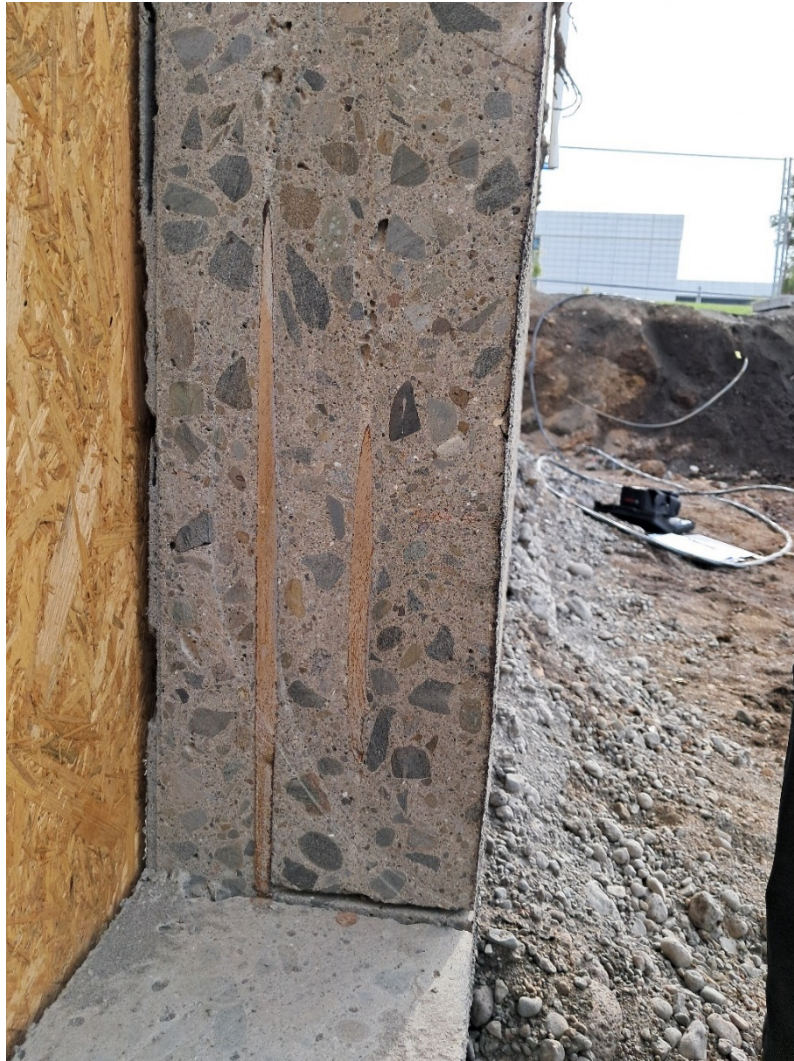
Mynd 2.4 - Nýtt gluggaop í suðurvegg. Sjá má marka fyrir lóðréttu steypustyrktarjárnri
