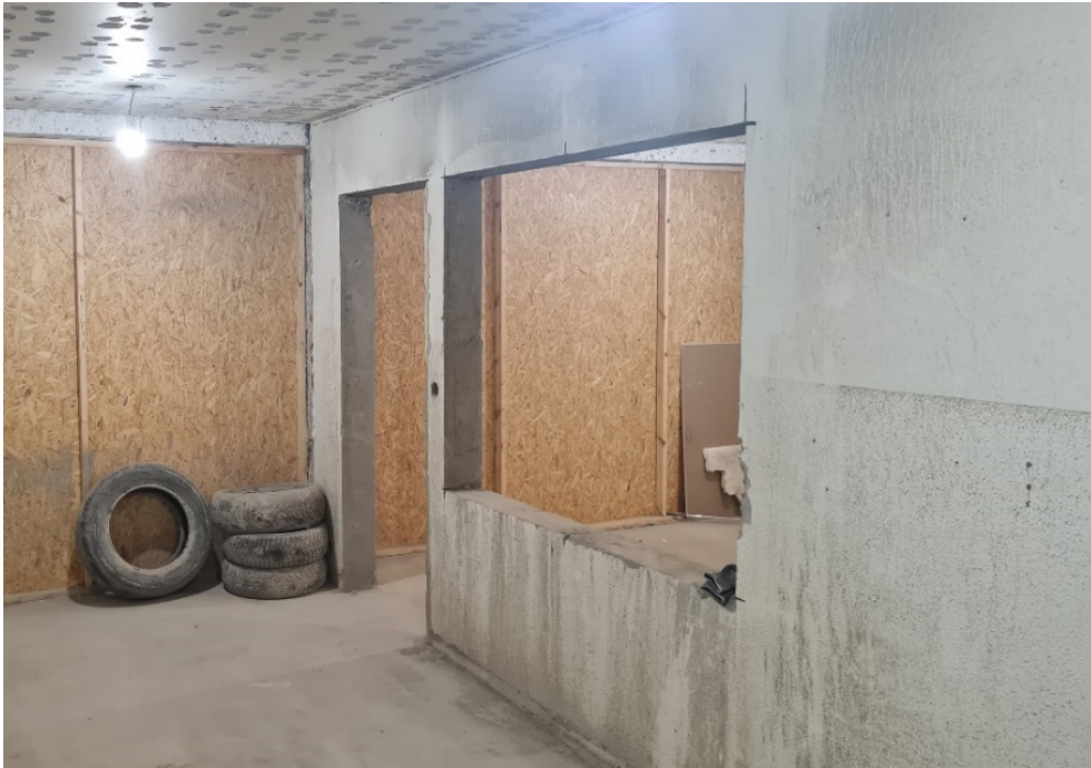
Mynd 2.7 – Nýtt gat í innvegg. Súlan milli dyraopsins og gluggaopsins er 150x200mm og þversnið hennar er rýrt af rafmagnsdós. Súlan sem eftir stendur er ekki með fullnægjandi járnbindingu.
