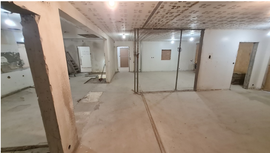
Mynd 2.9 - Hluti innveggjar hefur verið fjarlægður. Hér hefur verktafi sett stoðir undir þakplötuna í stað veggjarins sem var fjarlægður.
