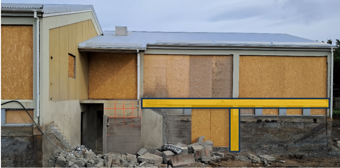
Mynd 3.1 - Nýr biti og súla í núverandi útveggjalínu ef kjallari er stækkaður (sýnt með gulum lit).
