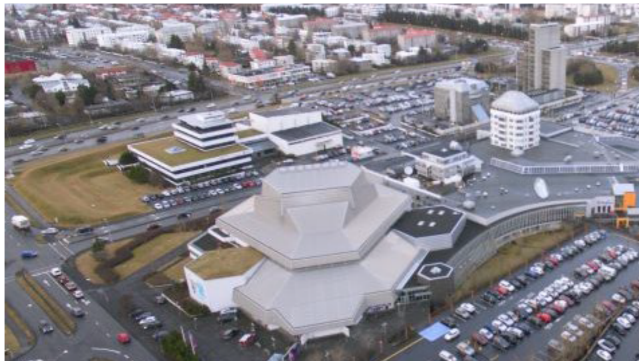
Kringlusvæðið - horft til vesturs
