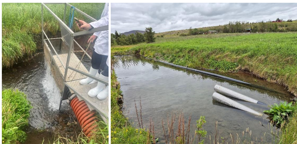
Mynd 6.1: fiskigildir við frárennslisvatni sem fer í skurð og fiskigildir í frárennslisvatni við settjörn sbr. mynd 6.2
