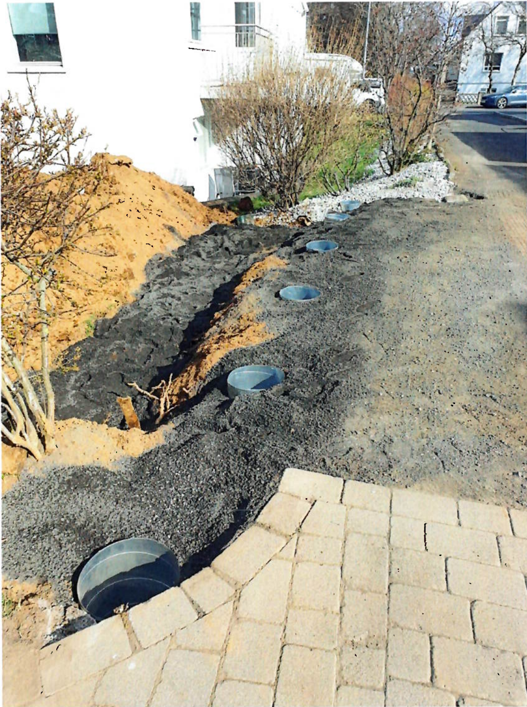
29. apríl 2024. Framkvæmdir byrjaðar við lóðamörk við innkeyrslu sem er sameiginleg húsa 24 og 26.
