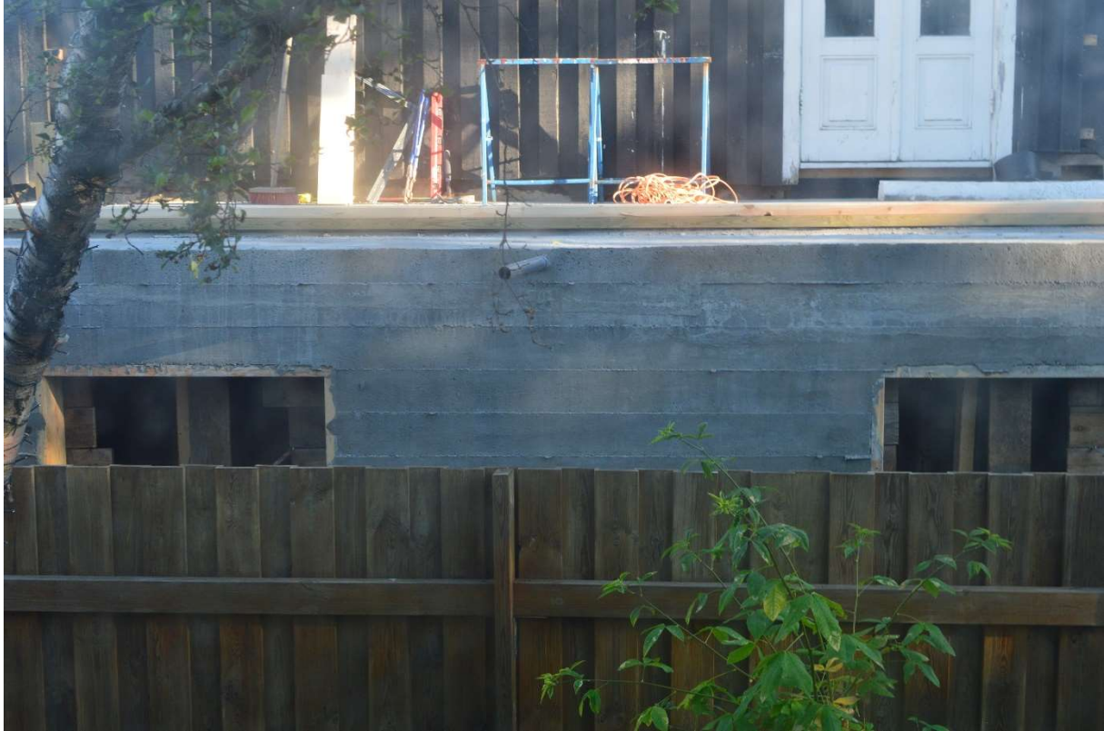
Mynd 3 Viðbygging séð úr eldhúsglugga nr. 6 (óþægilega nálægt)
