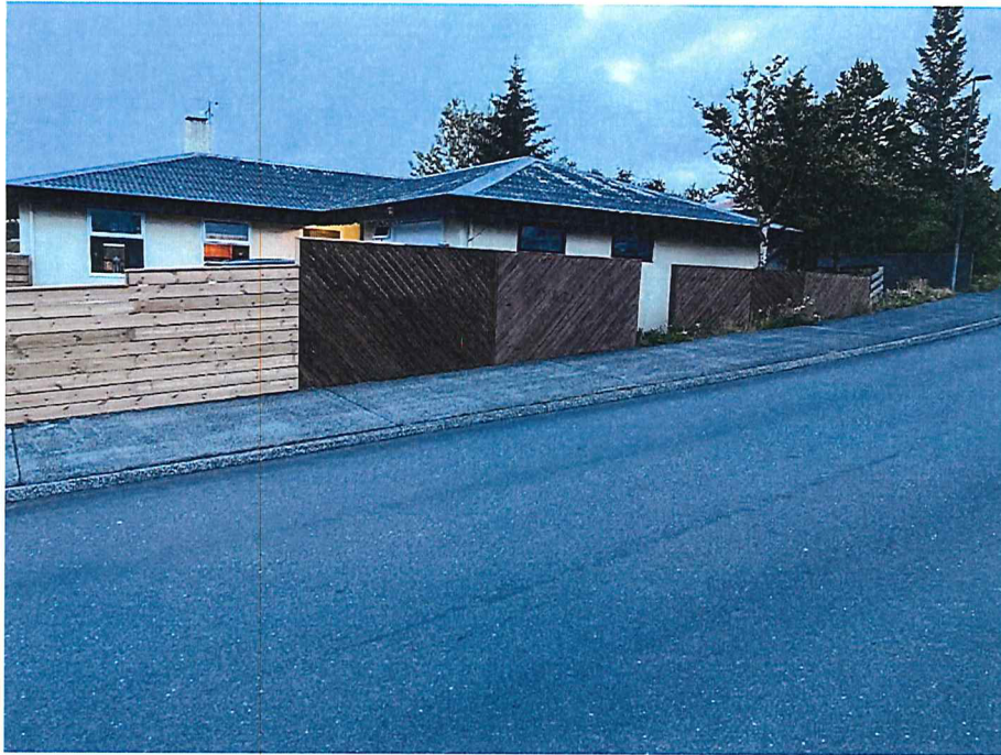
Mynd 5: Austurveggur við Hverafold 50, byggður 1992. Hæsta hæð 1,90 m og um 1,75 m yfir gólfkóta húss.
