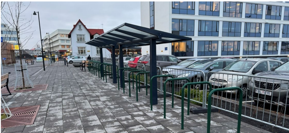
Mynd 4.5 Hjólastýli er í grunnin þak sem skýlir fyrir ofankomu. Það dugar þó skammt á Íslandi og æskilegast að stýli séu einnig lokuð á a.m.k. eina hlið.
