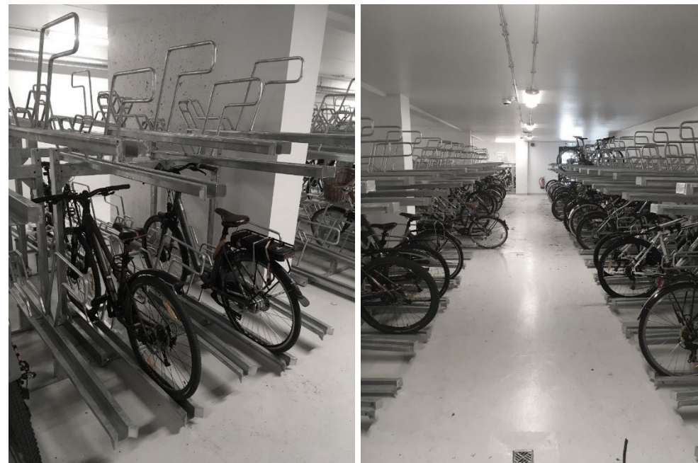
Mynd 4.1 Dæmi um lausn þar sem notaðar eru grindur á tveimur hæðum. Hér er góð lausn notuð þar sem grindurnar bjóða upp á auka stuðning og festingu fyrir hjólin. Þó mætti vera meira athafnarými fyrir aftan grindurnar.
