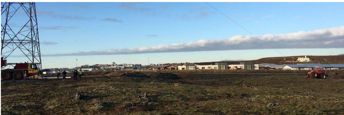
Mynd 3.2 Endamastur við Hamranes fellt 2019. Traktor með spil togar í topp mastursins.
