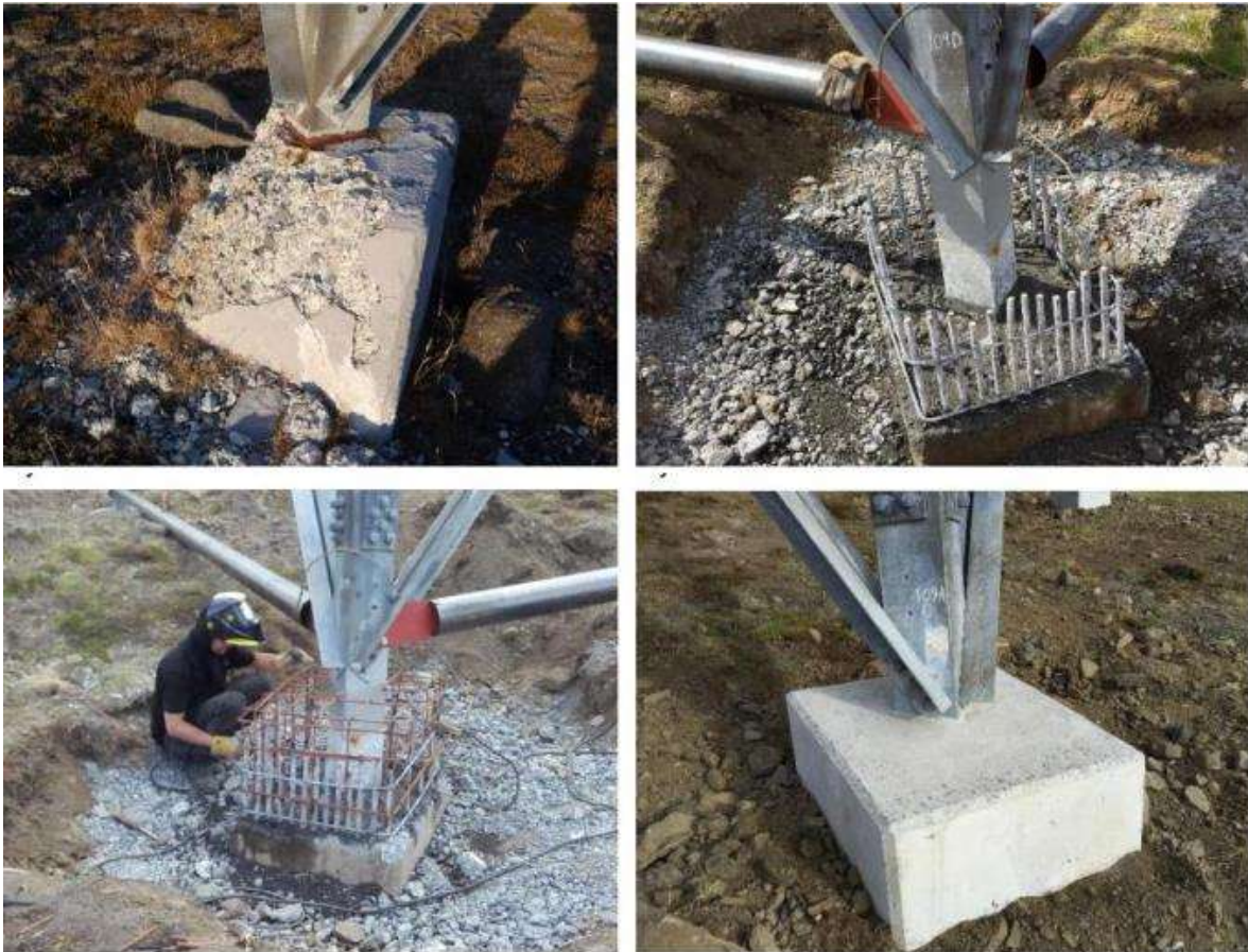
Mynd 3.8 Dæmi um viðgerð á undirstöðum. Viðgerð á undirstöðum á línu sem reist var 1977 í Hvalfirði (ljósmynd: Efla).
