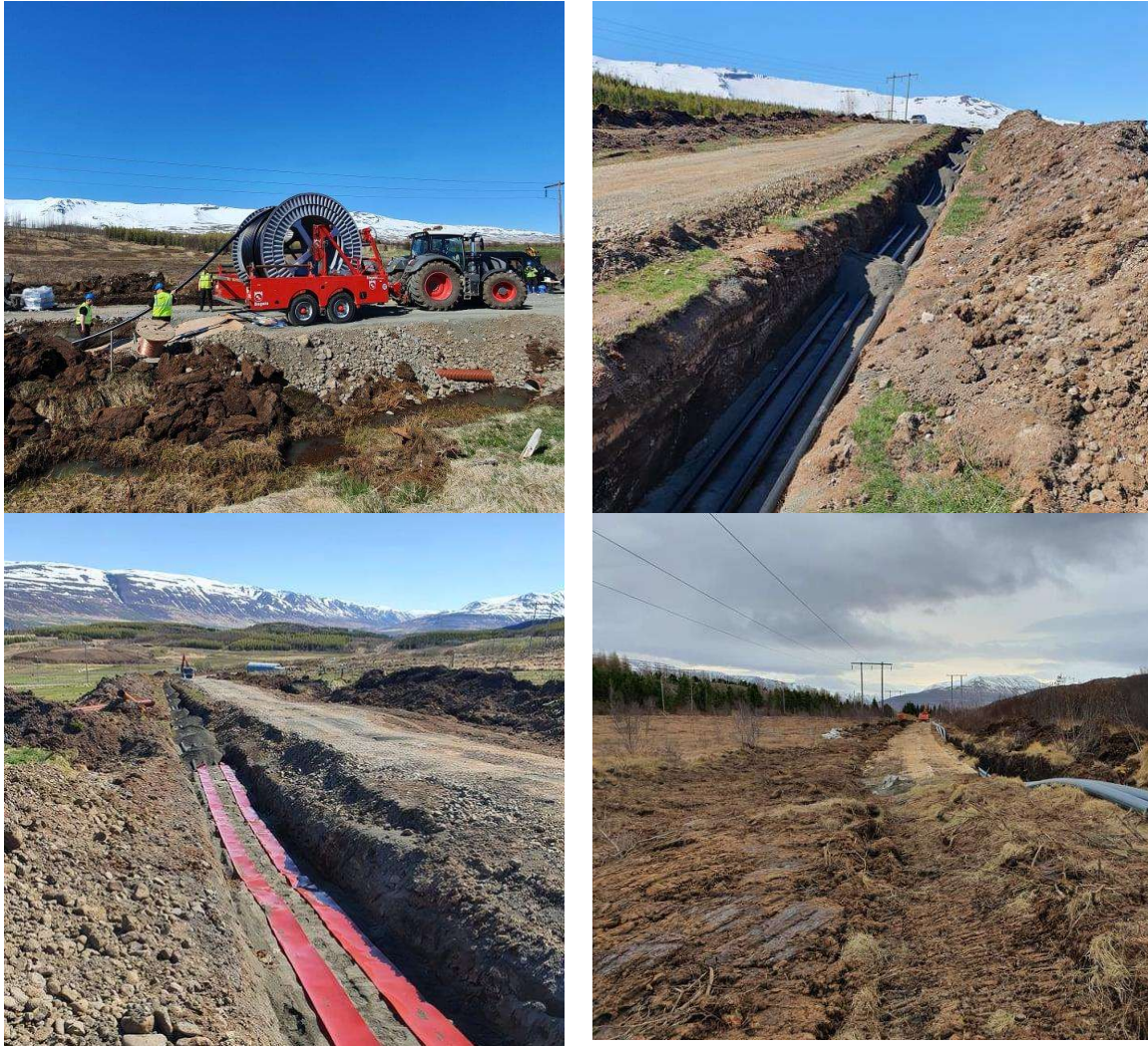
Mynd 3.5 Útdráttur strengs (Hólasandslína 3 á Akureyri). Uppi til vinstri er strengkefli á útdráttarplani og útdráttur í gangi. Uppi til hægri eru allir þrír leiðarar komnir í skurðinn og byrjað að sanda yfir. Niðri til vinstri er byrjað að leggja varnarborða yfir sandinn. Niðri til hægri er búið að loka yfir vinstri skurðinn en verið er að leggja ídráttarrör fyrir strenginn í hægri skurðinum.
