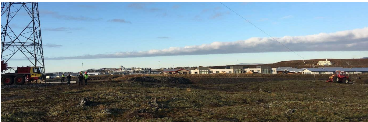
Mynd 3.2 Endamastur við Hamranes fellt 2019. Traktor með spil togar í topp mastursins.
