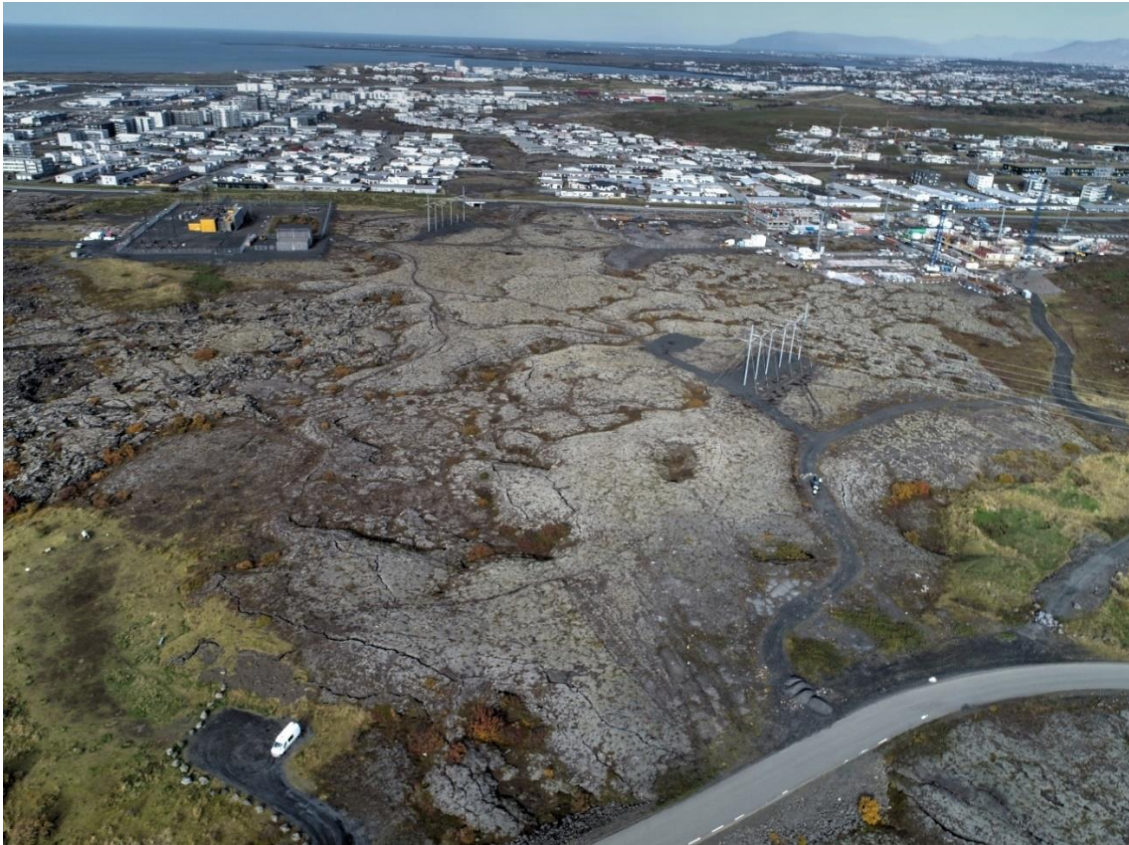
Mynd 4.4 Hraunmyndanir við tengivirkjó í Hamranesi. Á svæðinu má sjá Óbrinnishólhraun og Hellnahraun en erfitt getur verið að greina á milli þeirra.
