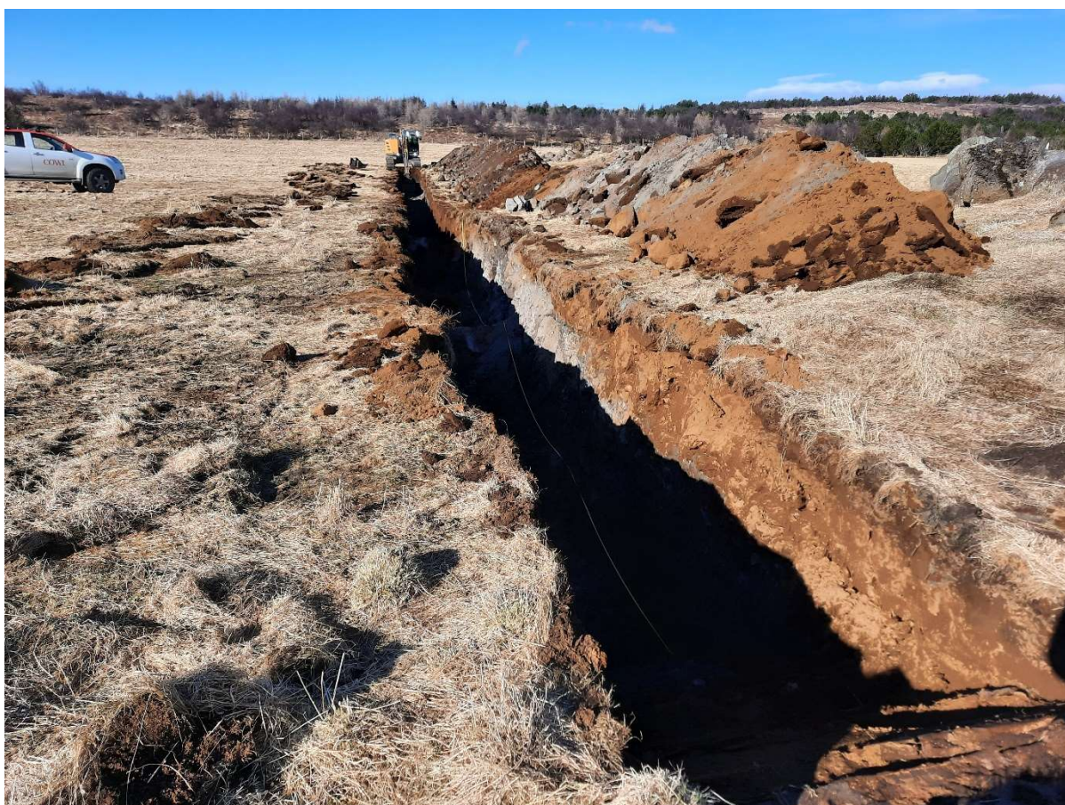
Mynd 2. Unnið við að grafa skurð 1. Gróðurtorfur voru teknar til hliðar til að loka skurðsárinu með þeim í yfirborðsfrágangi.
