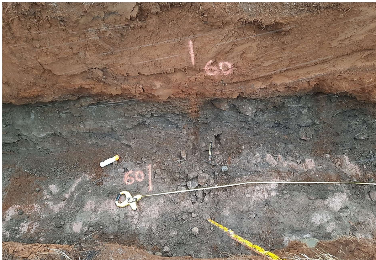
Mynd 16: Skurður 3, hægri veggur og botn. Virk sprunga í stöð 60.
