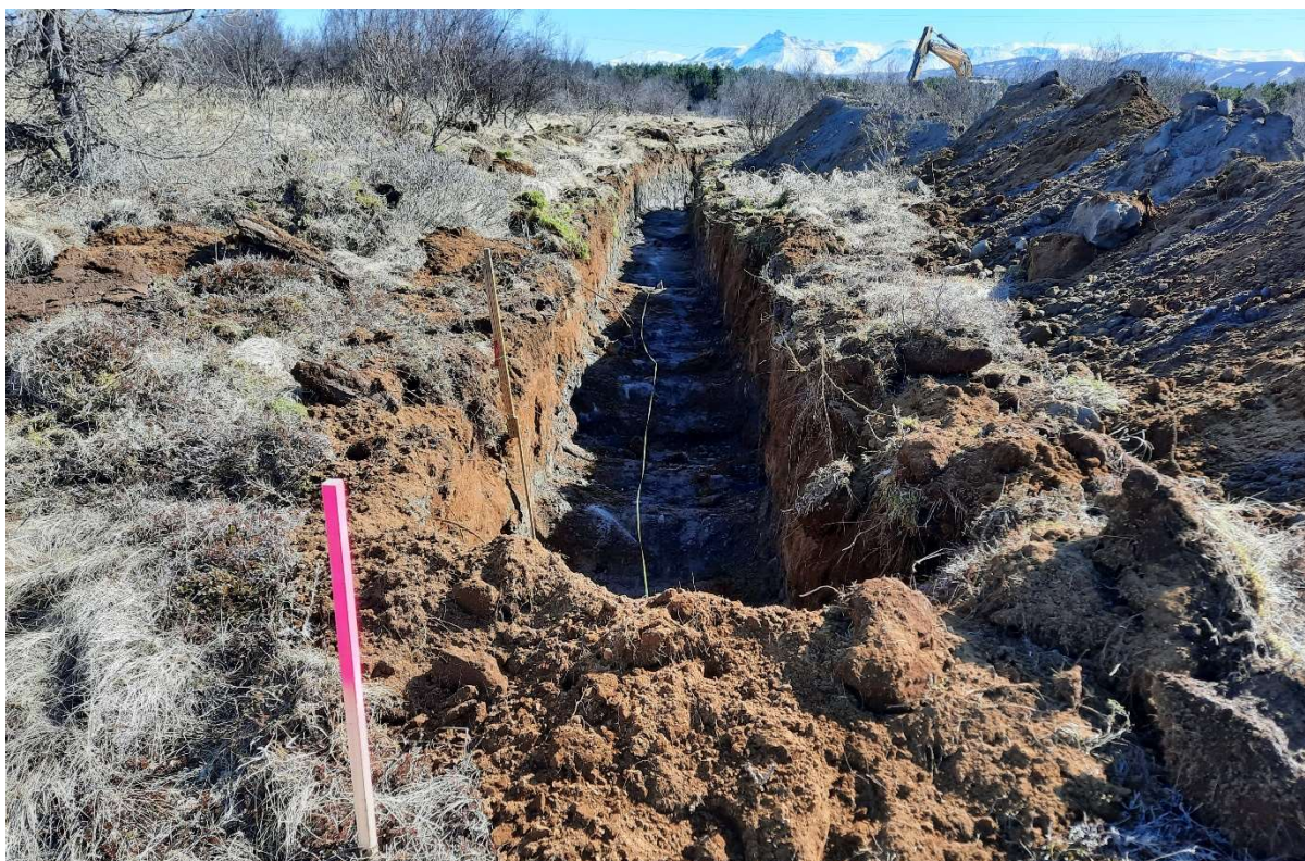
Mynd 39. Skurður 5. Horft til baka yfir skurðinn frá NV enda (stöð 111).
