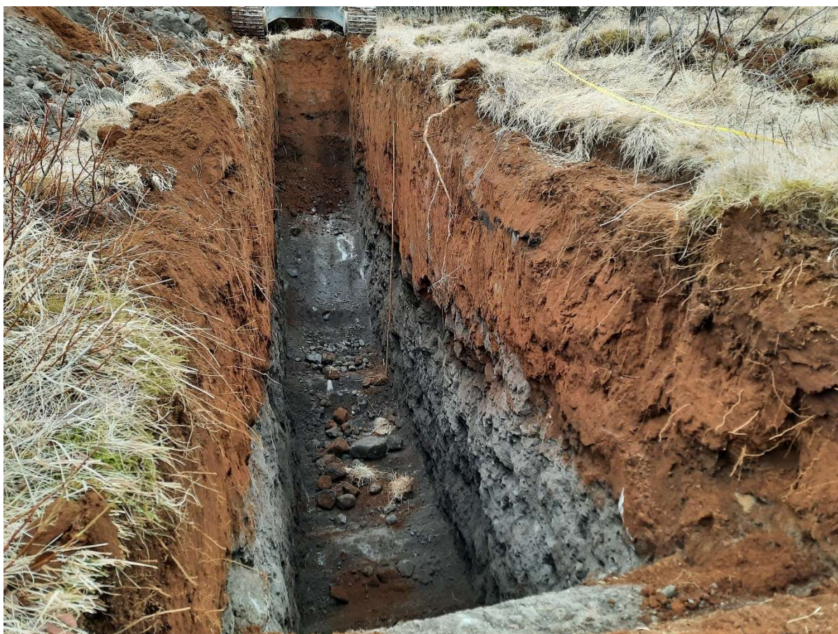
Mynd 9. Horft fram eftir skurði 7 frá stöð 0 (SA enda).
