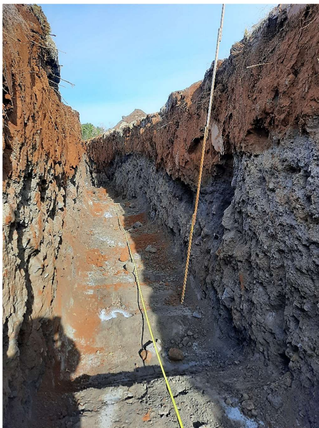
Mynd 30. Skurður 4 framlenging. Horft fram eftir skurðinum frá stöð 5.
