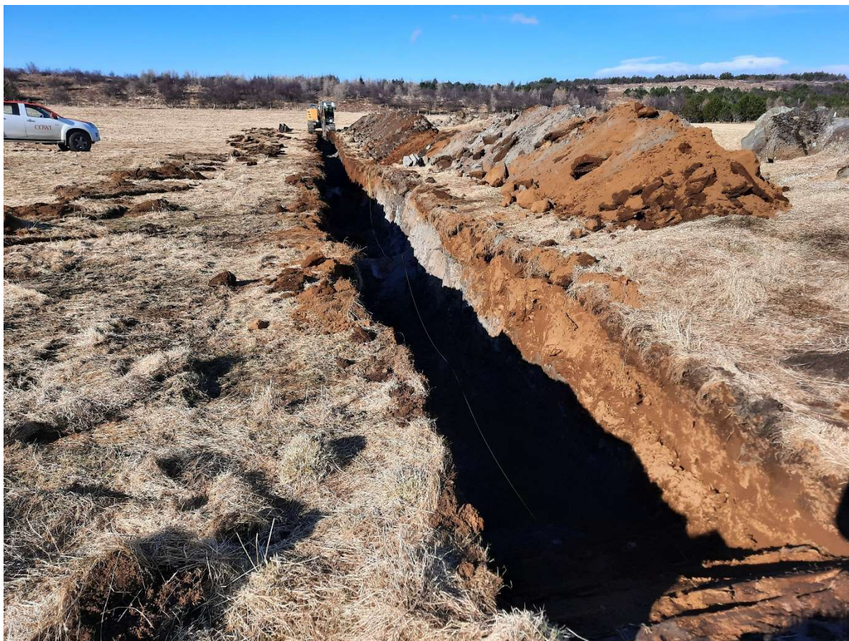
Mynd 2. Unnið við að grafa skurð 1. Gróðurtorfur voru teknar til hliðar til að loka skurðsárinu með þeim í yfirborðsfrágangi.
