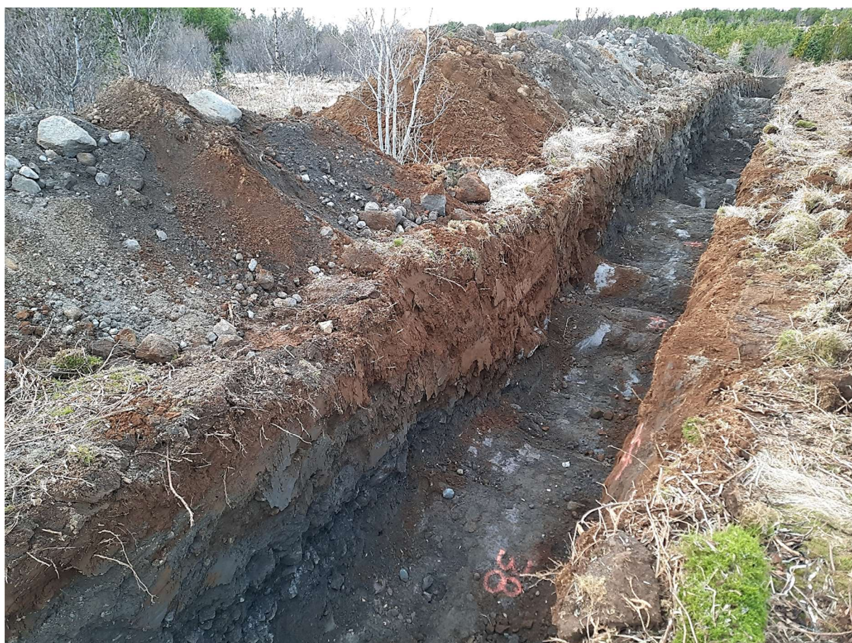
Mynd 4. Horft fram eftir skurði 2 frá stöð 38.
