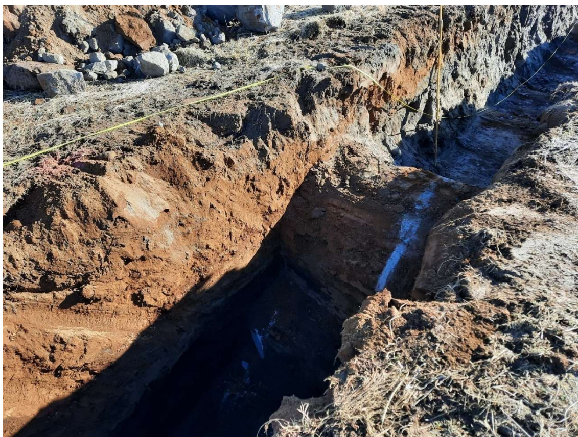
Mynd 2: Skurður 1. St. 20. Það mátti sjá "þröskuld" í botni skurðar. Milli st.20 og 47 var þykkt moldarjarðvegs töluvert meiri en sitthvoru megin við það svæði.
