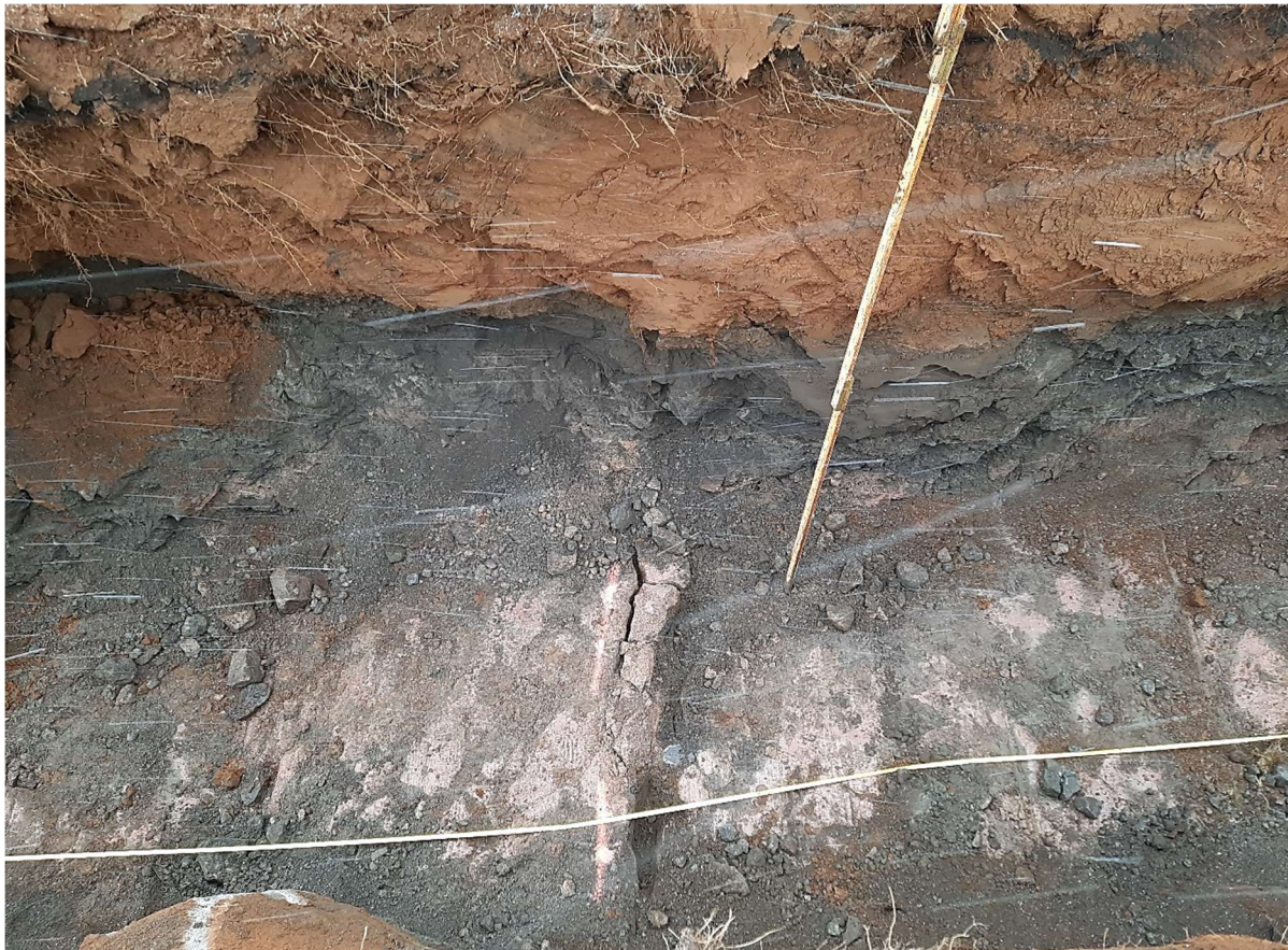
Mynd 18. Skurður 3, vinstri veggur og botn. Virk sprunga í stöð 66.
