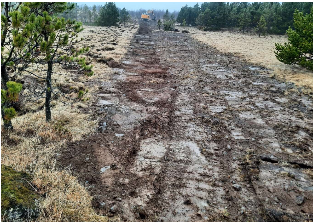
Mynd 22. Skurður 3, unnið við yfirborðsfrágang.
