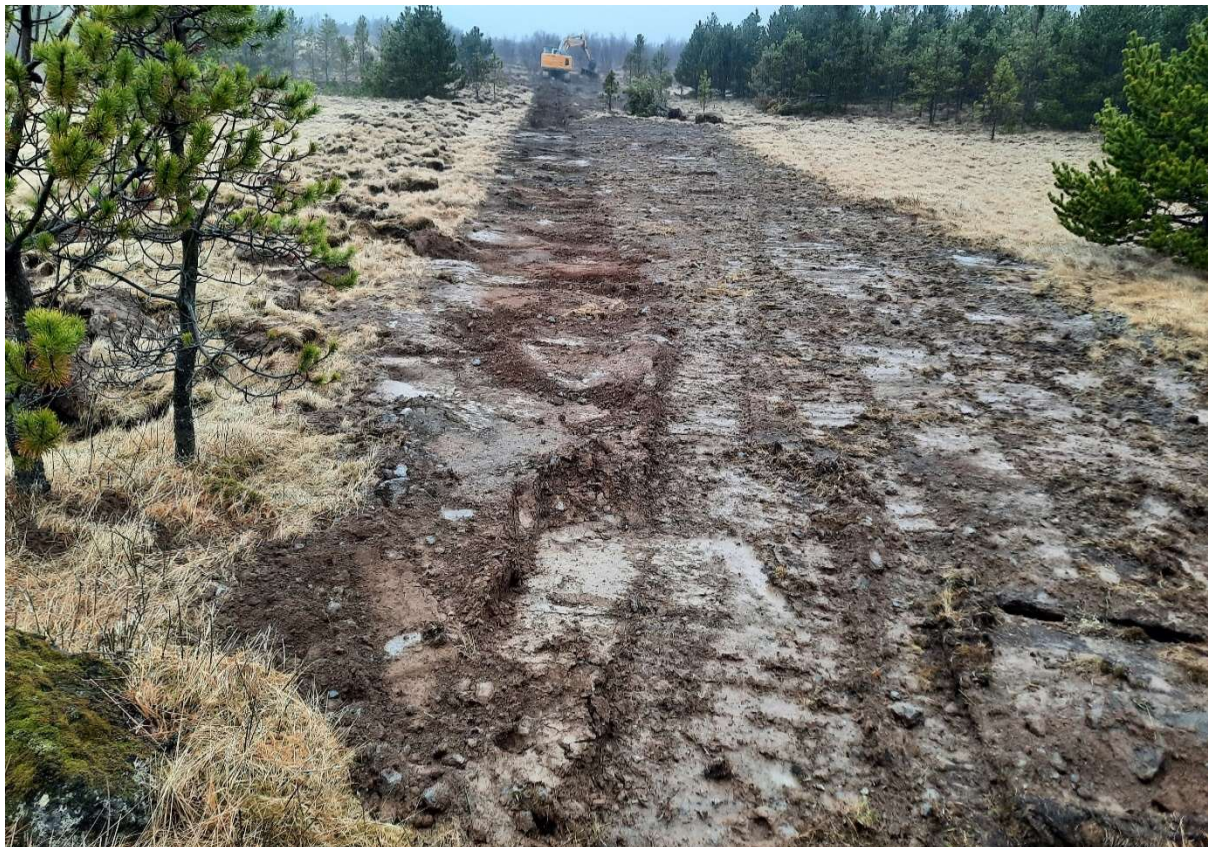
Mynd 22. Skurður 3, unnið við yfirborðsfrágang.
