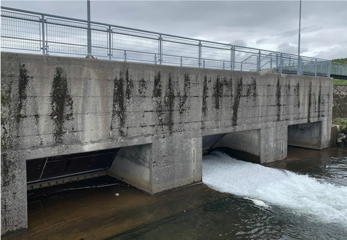
Mynd 12 Botnrásarvirki, ljósmynd loftmegin.
