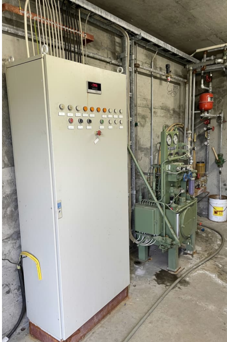
Mynd 23 Stjórn- og hitunarbúnaður geiraloka til vinstri og lokurými til hægri
