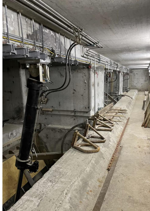
Mynd 23 Stjórn- og hitunarbúnaður geiraloka til vinstri og lokurými til hægri
