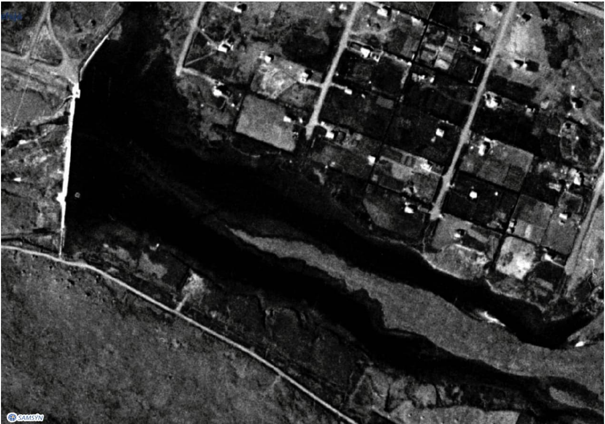
Mynd 5 Árbæjarlón í vetrarstöðu 1954, loftmynd
