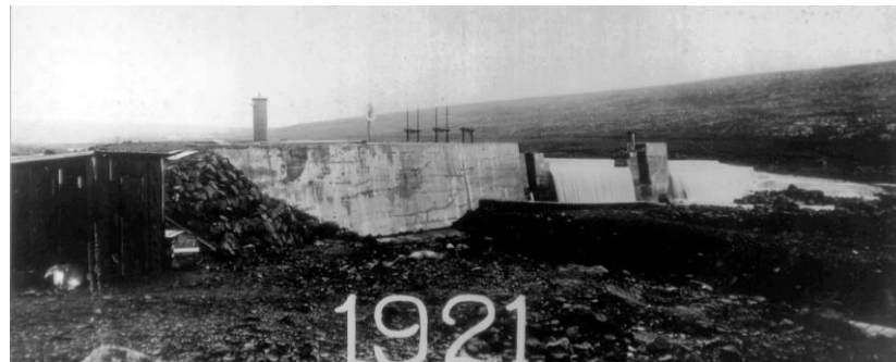
Árbæjarstífla í byggingu
