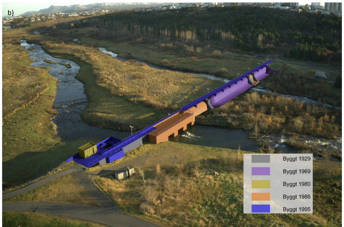
Mynd 8. Úr skýrslu Verkis frá júlí 1923. Saga Árbæjarstíflu: útlitsbreytingar frá 1920 til 2023: Elliðaárvirkjun. Myndin sýnir þrívíddarlíkan af Árbæjarstíflu í núverandi mynd. Litir á stíflunni sýna frá hvaða tíma hver hluti stíflunnar er. Grátt er frá 1920-1929.
