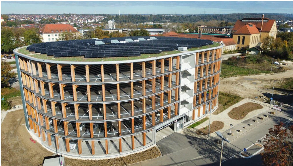
Mynd 5.2: Bílastæðahúsið Holzparkhaus Wendlingen er byggt úr forsmíðuðum timbureiningum sem geri kleift að breyta byggingunni eða taka hana í sundur (Wendlingen am Neckar, án dags.)
