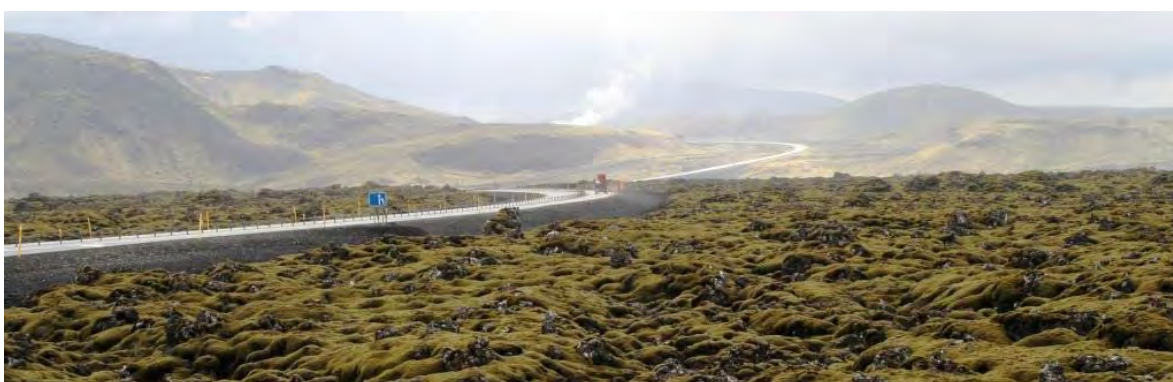
Mynd 4-24 Nýr vegur í Svínahrauni er lagður á landið en ekki ýtt upp.
