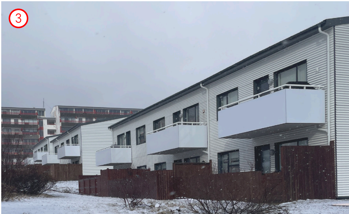
3.Suðurfell – 2. hæða fjölbýlishús með litlum einkagörðum vestan megin og bílastæðum austan megin.
