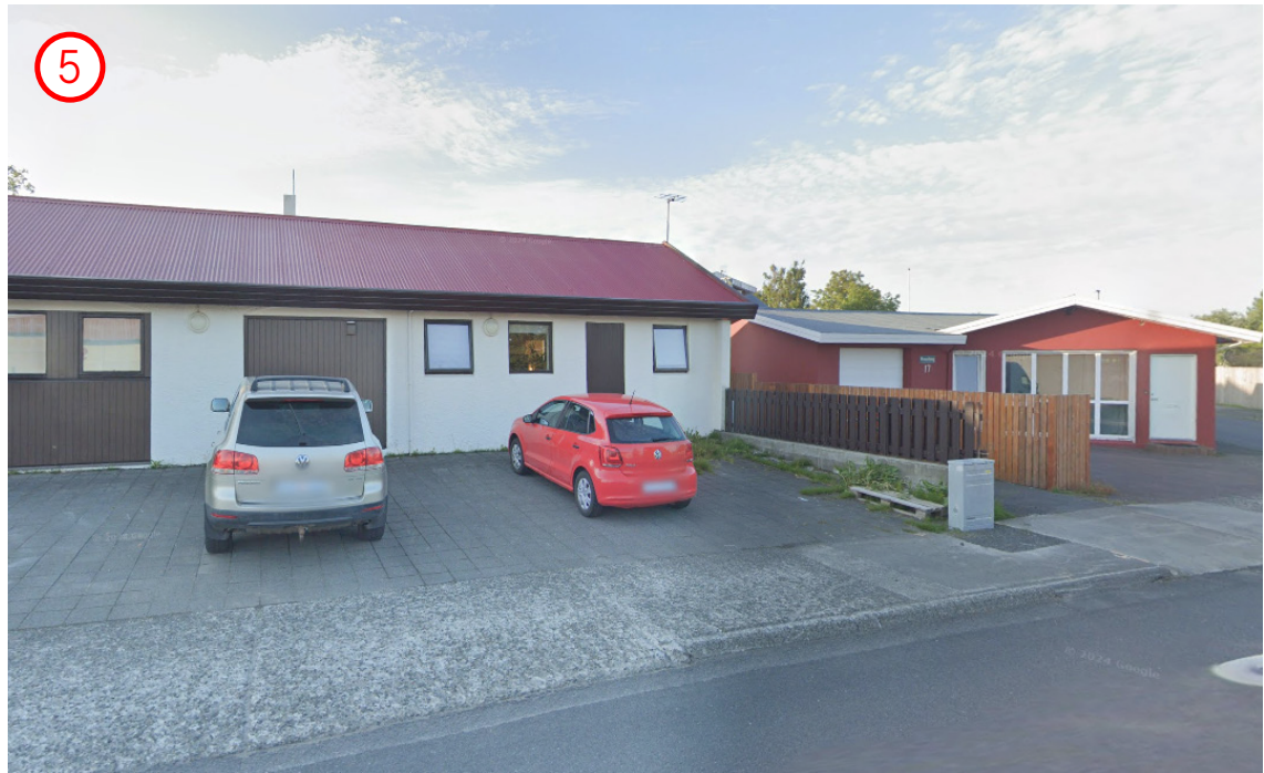
5.Hraunberg – Einbýlishús á einni hæð með bílageymslur fyrir framan
