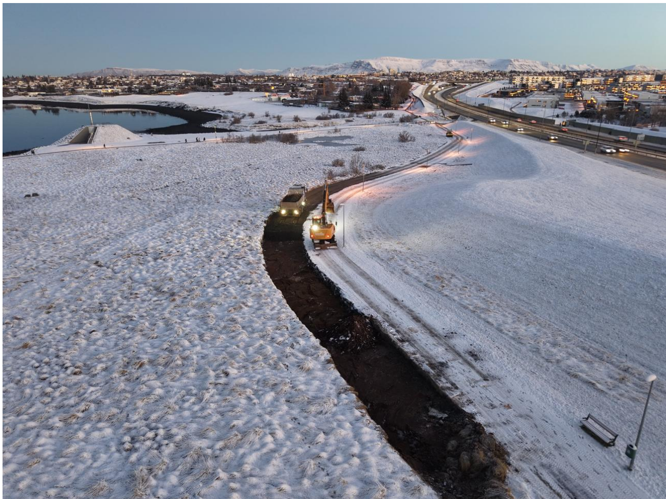
Framkvæmdir í Garðabæ, vestan við Hafnarfjarðarveg.
