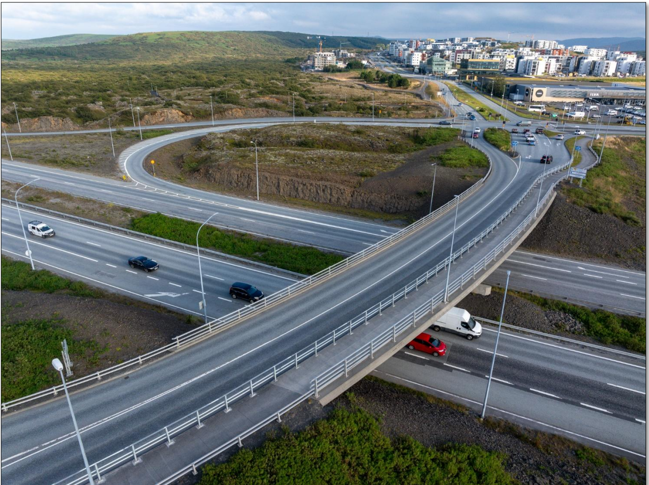
Vegrið við gangstétt á brú við Kauptún yfir Reykjanesbraut.
