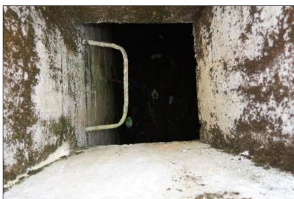
Mynd 36. Horft niður í brunni.
