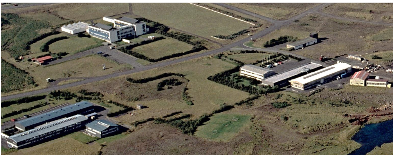
Mynd 13. Keldnaholt 1998. Lengst til vinstri eru hús tengd Iðntæknistofnun (Árleynir 8 og 8a), þá hús RALA (Árleynir 22), en til hægri má sjá Straumfræðihús (Árleyni 2a), þrjú hús RB (Árleynir 2) og loks elsta húsið á svæðinu sem reist var 1957 á vegum raforkumálastjórnar (lóðin Árleynir 4) en það er nú horfið. 97
