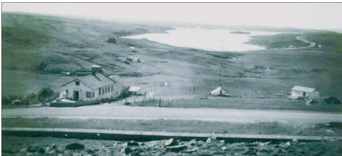
Mynd 24. Horft til vesturs ofan úr Grafarholti út yfir Grafarvog. Fremst þvert yfir myndina er hitaveitustokkurinn og Mosfellssveitarvegur. Þar fyrir neðan er Grafarholtsbærinn og sambyggð útihús til vinstri, þá stakt útihús (260-212) á miðri mynd og Pétursborg (260-204). Fjær er rafstöð (260-213) við Grafarlæk, sumarhúsabyggð á Nónholti, heimreið að Keldum og bæjarhóll Grafar til hægri. Fyrir botni Grafarvogs er nýr vegur að Gufunesi. 88
