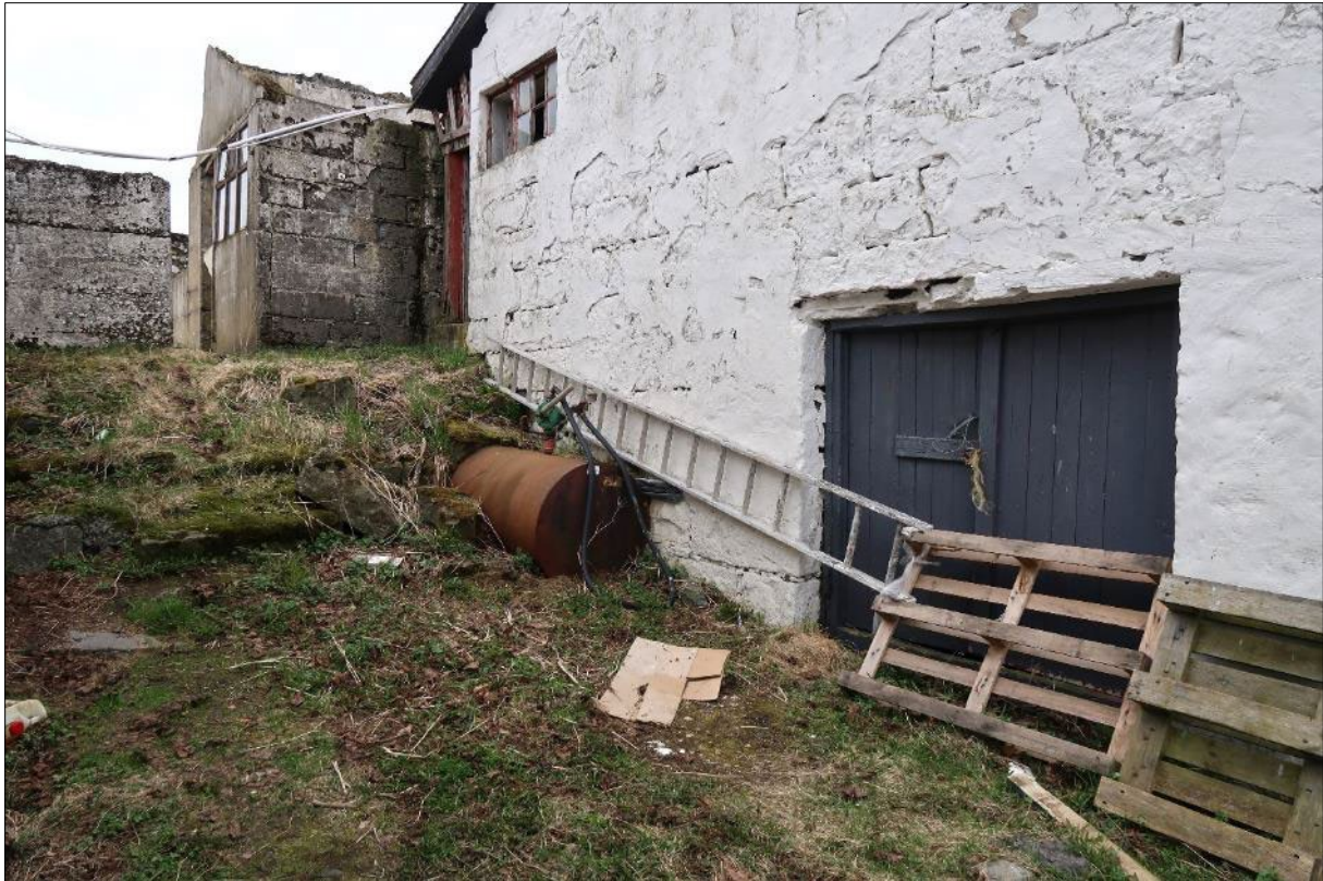
Mynd 81. Horft til norðausturs upp sund á milli bygginga á Keldum. Til hægri eru steinhlaðið haughús og fjós byggð 1920. Efst eru útihús (264-44) sem byggð voru 1935.
