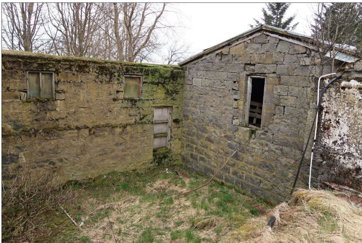
Mynd 80. Horft til vesturs yfir hlöðuna. Til hægri er fjós og haughús, veggir hlaðnir úr tilhöggnu grjóti.
