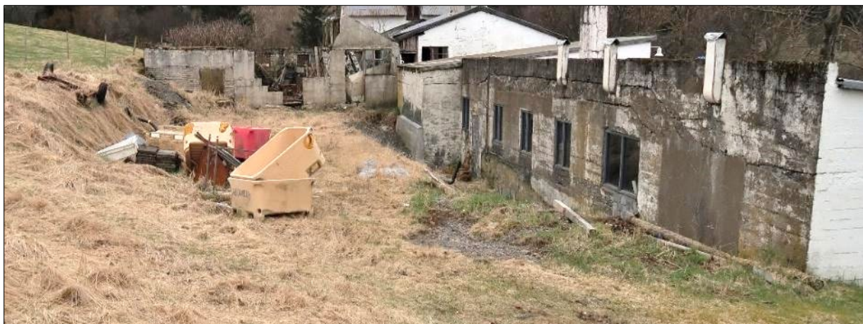
Mynd 82. Horft til suðausturs að fjárhúsi og hlöðu, þaklausum. Til hægri er bílskúrin, þvottahúsið og hesthúsið, Keldnavegur 19.
